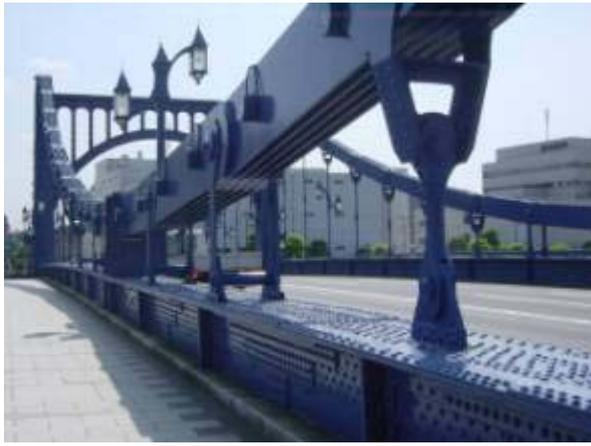
図 11.1 清洲橋(1928)自碇式チェーン吊橋
