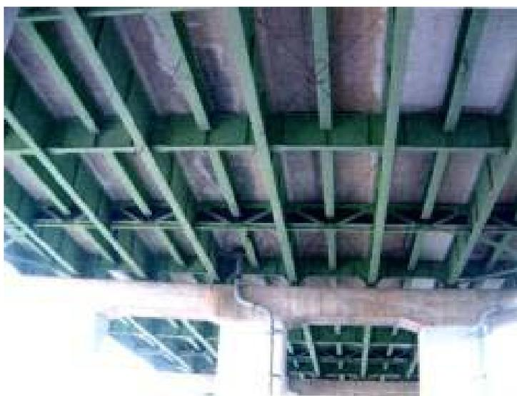
図 9.1 共和高架橋の主桁と床組みを示した写真
