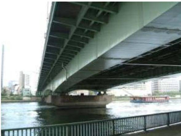
図 11.5 佃大橋(1964)鋼連続二箱桁橋
