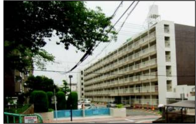
図 A1 振動観察対象の六階立てのマンション
