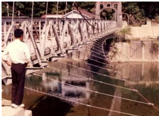
図7 耐風索を配置した小規模の道路橋吊橋 愛知県天竜川上流、錦橋(おきんばし)
