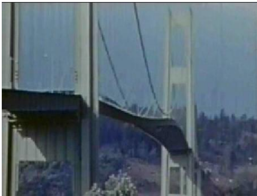
図 11 タコマ吊橋が風を受けて振動した 16mm ムービー (Prof. Farquharson) 1940 インターネットで動画で見ることができます。
