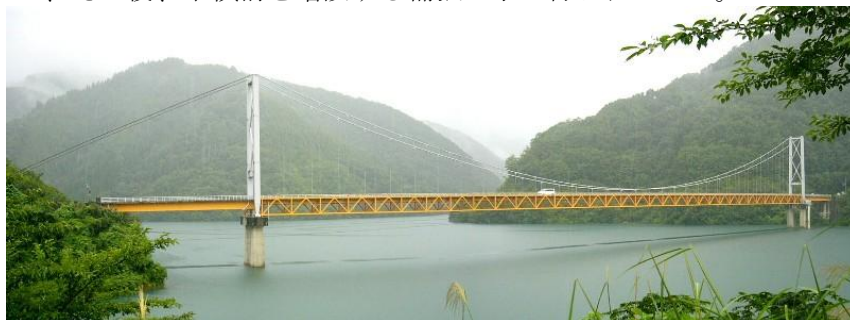
図8 箱ヶ瀬橋、(福井県九頭竜ダム湖)。瀬戸大橋のテストケースにした吊橋
