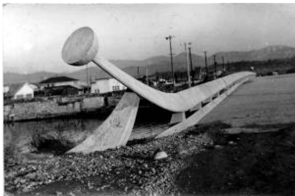
図9 平和大橋の橋端での高欄デザイン
