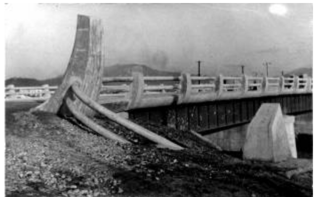
図10 西平和大橋の橋端の高欄
