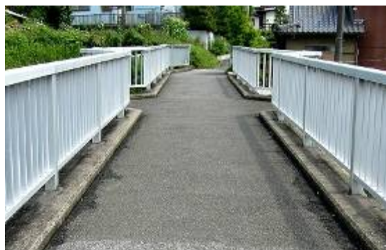
図 14 歩行者用退避所を設けた一車線の道路橋 有松橋
