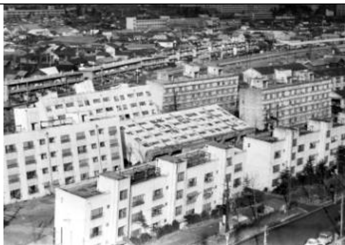
図 2. 地盤の液状化で傾いたアパート群
