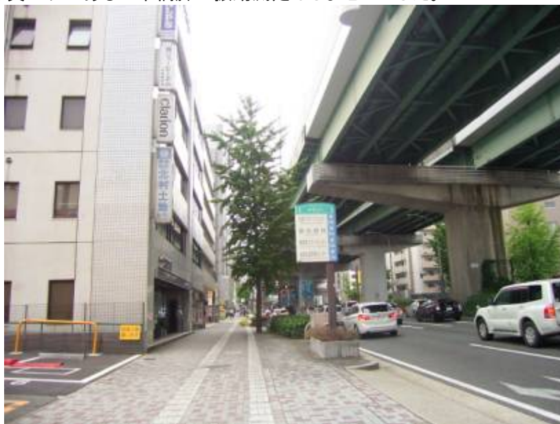
図 12. 道路沿線の写真
