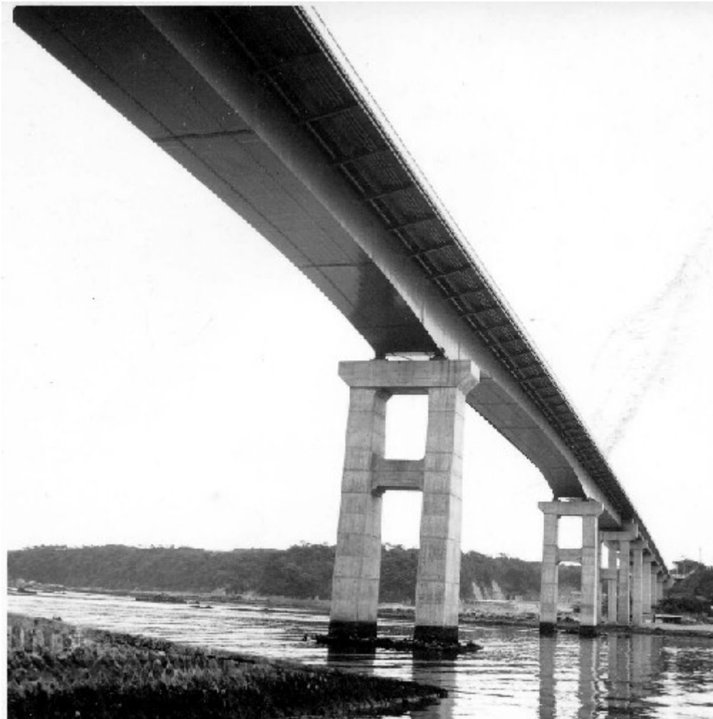
図 10 城ヶ島大橋(三径間連続鋼床版箱桁、70+95+70m、幅員 2+7+2m、箱桁ウェブ間隔 4.5m)
