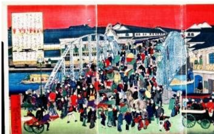
図 16. 大阪心斎橋の開化絵(1875)。トリミングしてあります 錬鉄のポニー構造です。
