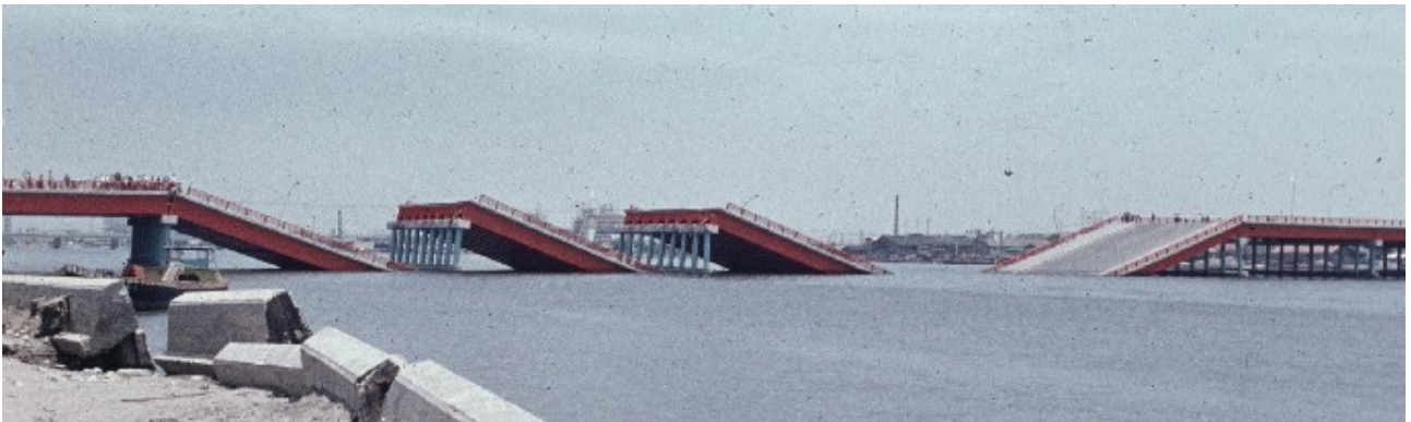
図5 昭和大橋の落橋（撮影：倉西 茂）
