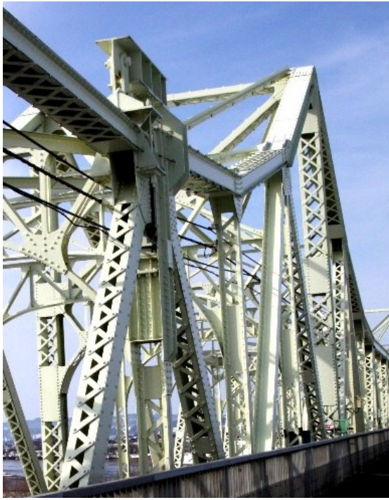
図3 長生橋の吊り構造部の外観（改造後）
