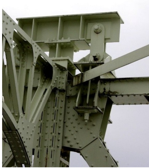
図4 橋軸方向の変位を許す上弦材ヒンジ構造
