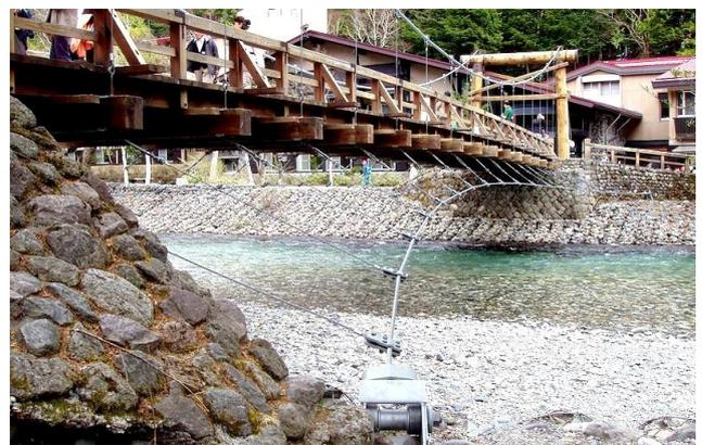
図12 長野県上高地の河童橋(ウイキペディア)木造の、塔、床組、高欄、そして耐風索が見えます歩道専用の無補剛吊橋です
