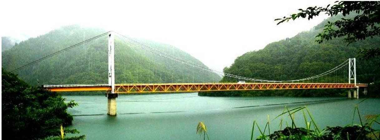
図 15 箱ヶ瀬橋、(福井県九頭竜ダム湖)。瀬戸大橋のテストケースにした吊橋
