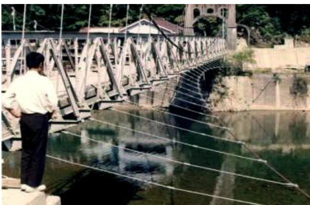
図11 静岡県天竜川上流、錦橋(おきんばし)ポニー形式の補剛トラスを使って重量車も通ります。耐風索を配置してあることに注目
