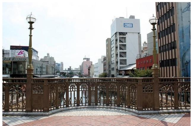
図24 納屋橋の高欄と歩道張り出しのデザイン
