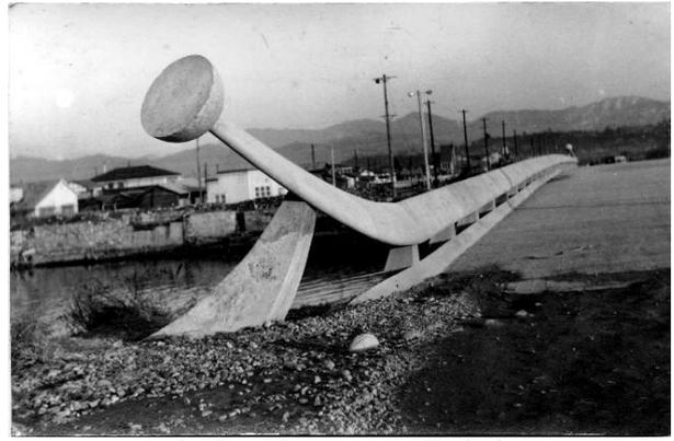
図20 平和大橋の橋端での高欄デザイン(完成時)
