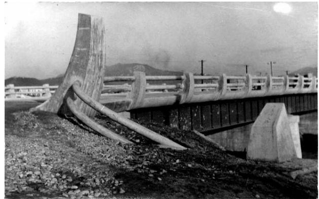
図21 西平和大橋の橋端の高欄
