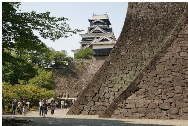
図9 熊本城の武者返しの城壁(ウィキペディア) 熊本地震(2016)による被災前の写真
