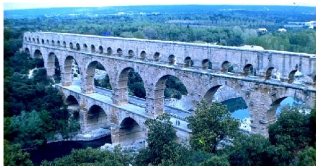
図5 ガール水道橋,19BC, 典型的な半円弧の石造アーチ(撮影:倉西 茂)
