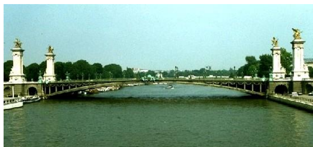
図 13 アレキサンダー三世橋、パリ、1890、 鋼アーチ、ライズの低さに注目(撮影 倉西 茂)
