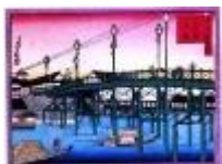
MK524. 高麗橋。「阪府新名所高麗鉄橋」。1880. 貞信II。明治3年に完成した大阪最初の鉄橋。橋桁から欄干まですべて鉄材。資材はロンドンからの輸入。大阪開化絵
