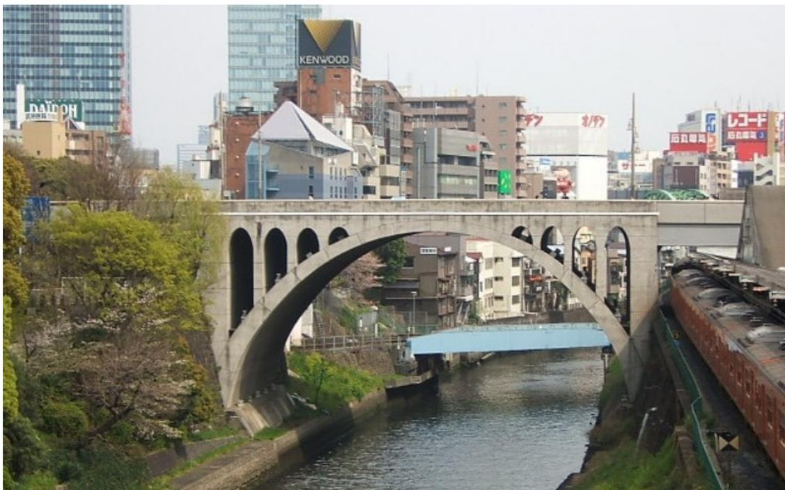
図4. 聖橋；橋長 91.8m、アーチ支間 31.4m は全長の約 1/3 です（インターネットより）。
