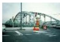
国道1号、1)下路ランガートラス、2)トラス1933、ランガートラス-設計上はトラス下弦材中央にヒンジあり。製作は剛結担当は愛知県尾張大橋架設事務所(所長 田島 治身)、
