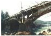
A30051.jpg、鹿乗橋、かのり、愛知県、瀬戸市鹿乗町～春日井市高蔵寺、庄内川、県道柴乗西尾線(元)県道春日井瀬戸線、旧・鋼アーチ橋は1910(明治43)年5月完成 橋長72.6m 幅員3m 鋼上路2ヒンジトラスドリブアーチ橋
