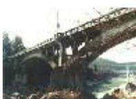
A30051.jpg、鹿乗橋、かのり、愛知県、瀬戸市鹿乗町～春日井市高蔵寺、庄内川、県道柴乗西尾線(元)県道春日井瀬戸線、旧・鋼アーチ橋は1910(明治43)年5月完成 橋長72.6m 幅員3m 鋼上路2ヒンジトラスドリブアーチ橋
