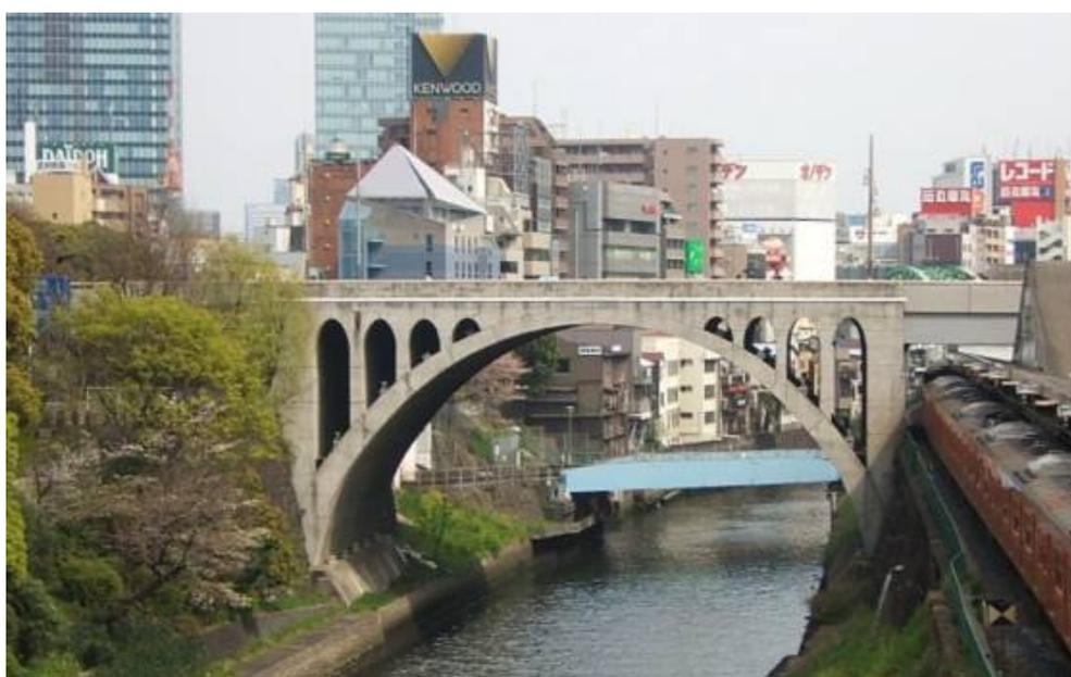
図 3.7 聖橋；橋長 91.8m、アーチ支間 31.4m は橋長の約 1/3 です（インターネットより）。
