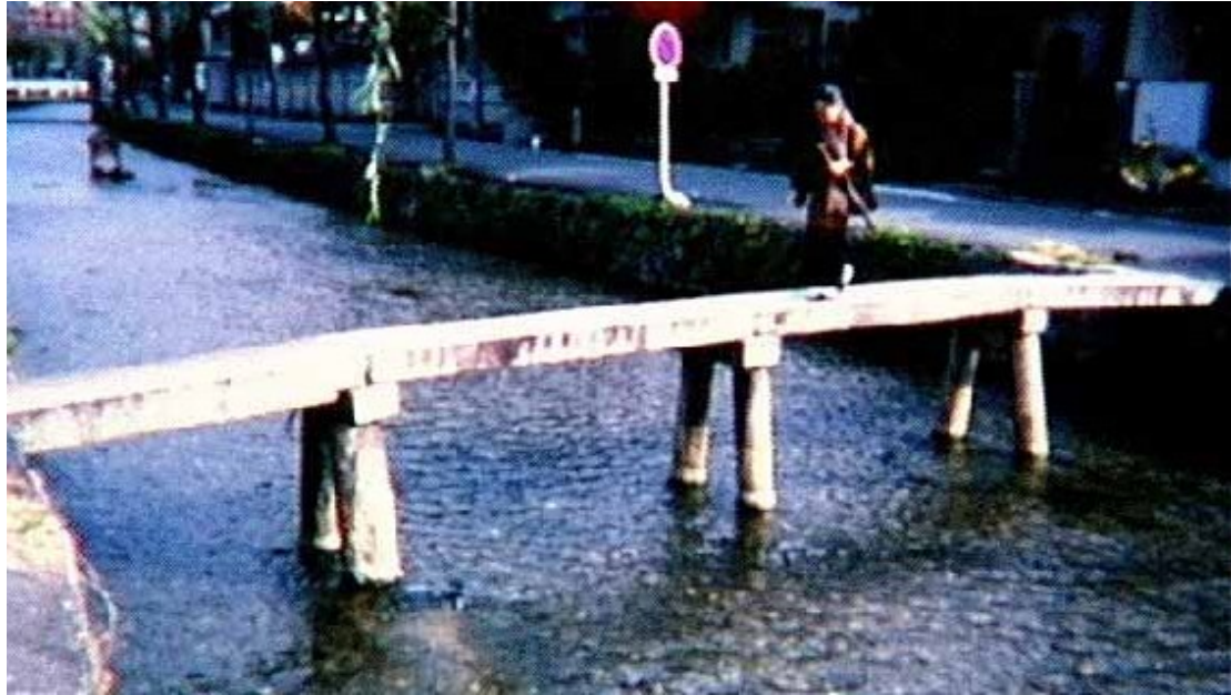
図1 行者橋：京都白川に架かる石の桁橋、建設年不明、（撮影：宮下力）
