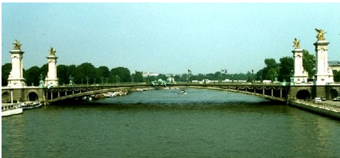
図4 アレキサンダー三世橋, パリ, 1890, 鋳鋼アーチ, ライズの低さに注目 (倉西 茂)
