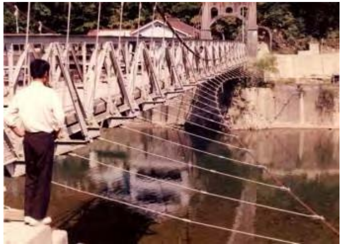
図 10.4 耐風索を配置した小規模の道路橋吊橋 愛知県天竜川上流、錦橋(おきんばし)
