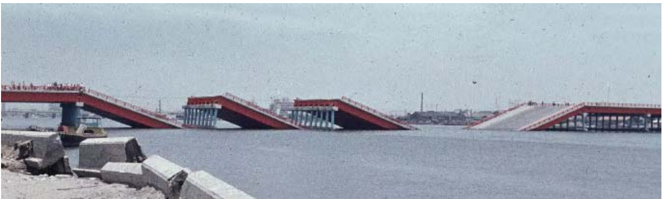
図 12.5 昭和大橋の落橋（撮影：倉西 茂）
