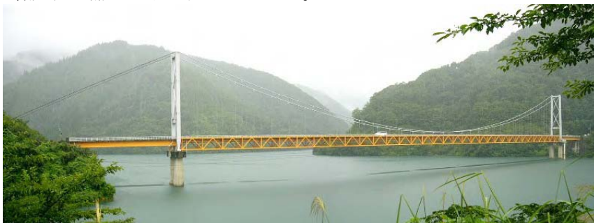
図 10.5 箱ヶ瀬橋、(九頭竜ダム湖)。瀬戸大橋のテストケースにした吊橋
