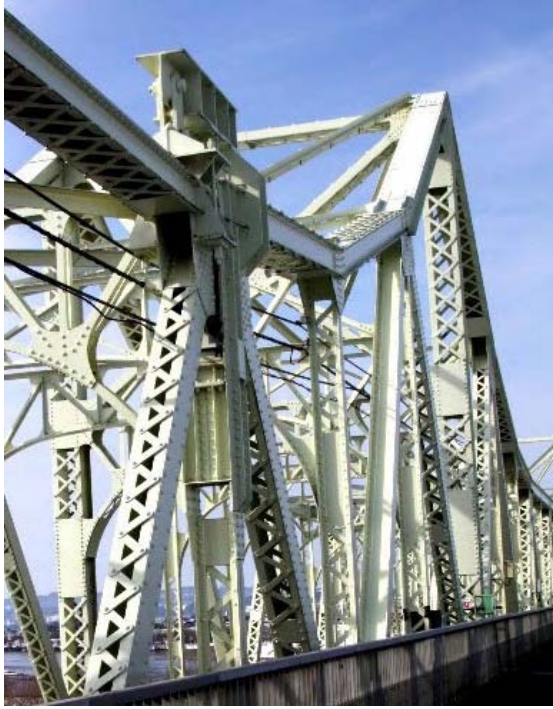
図 12.3 長生橋の吊り構造部の外観
