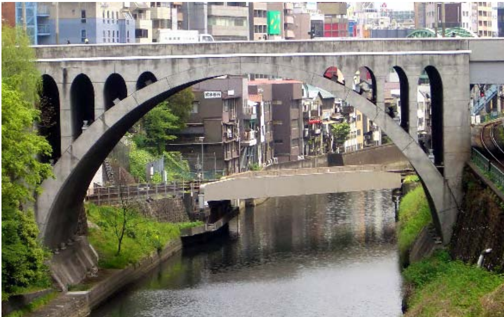
図 14.2 聖橋(1927)、鉄筋コンクリート造のオープンスパンドレルアーチ(撮影: 藤原稔)
