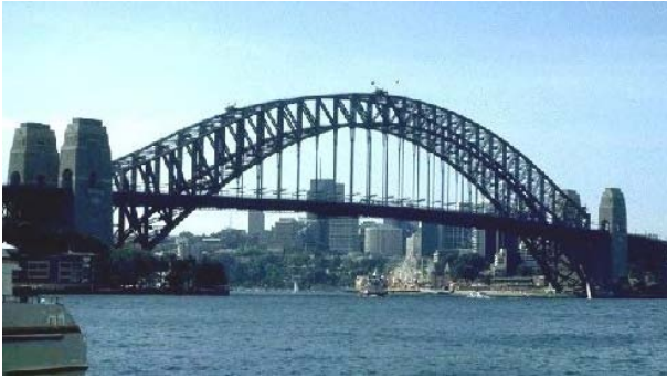
図 14.6 シドニーハーバー橋(1931 : 撮影倉西茂)
