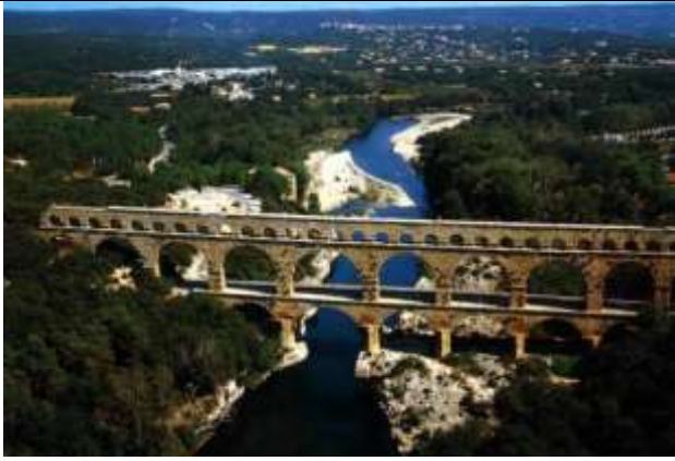
KWM016, ガール水道橋
