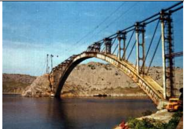
KWM048,カーク橋,張出し架設中
