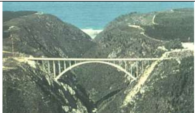
KWM044,ブルックランス橋,
