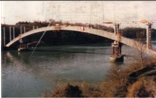
KWM050, シャトーブリアン橋, 上床版施工中
