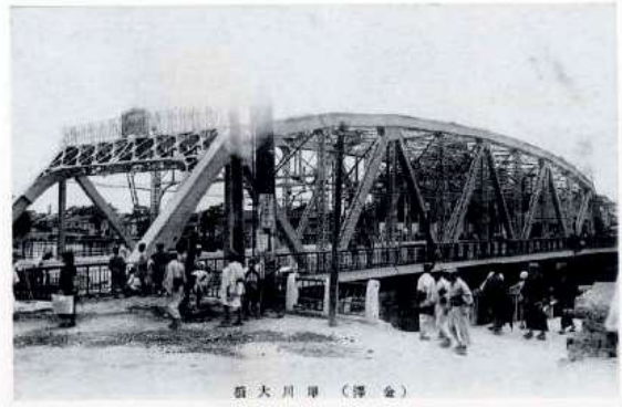
KJK218.犀川大橋、石川県金沢市、犀川、1924、トラス橋による復旧工事
