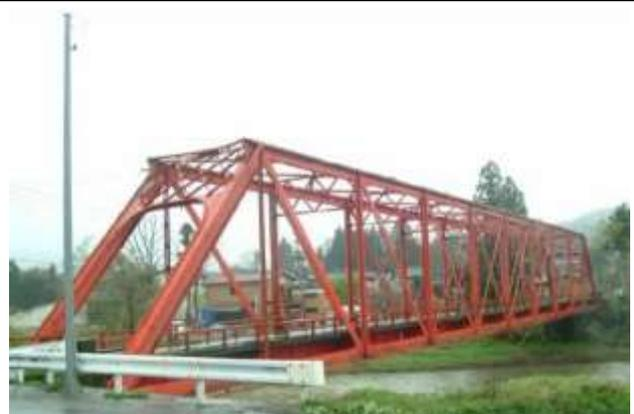
KJK152.不動沢橋(1959/1888)(市道)新潟県長岡市越路町(渋梅川)信越本線越路橋梁, 1959年道路橋に移設, ハンディサイド製(84)と同時
