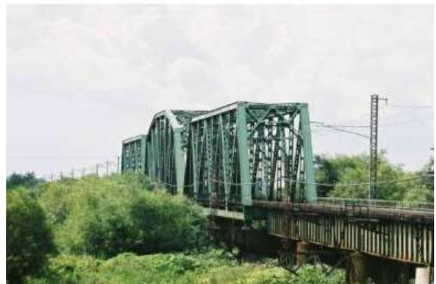
KJK144.石狩川橋梁(北海道 1956/1927)(JR 函館本線下り線)北海道滝川市-妹背牛町(石狩川)曲弦ワレントラスのみ旧線橋梁から移設再利用
