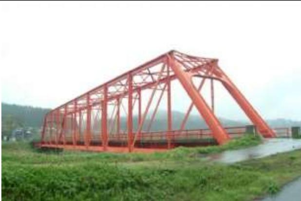
KJK151.岩田橋(1959/1888)(県道)新潟県長岡市越路町(渋梅川)信越本線越路橋梁, 1959年道路橋に移設, ハンディサイド製(84)と同時
