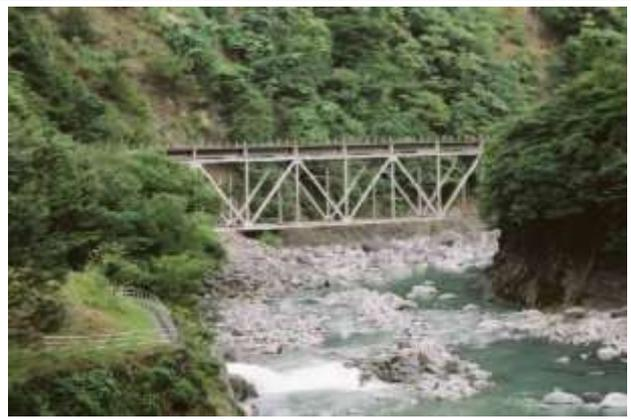
KJK136.第一大井川橋梁(1953/1936)(大井川鉄道井川線)静岡県川根本町(大井川)飯田線遠山川橋梁ワレントラスを移設
