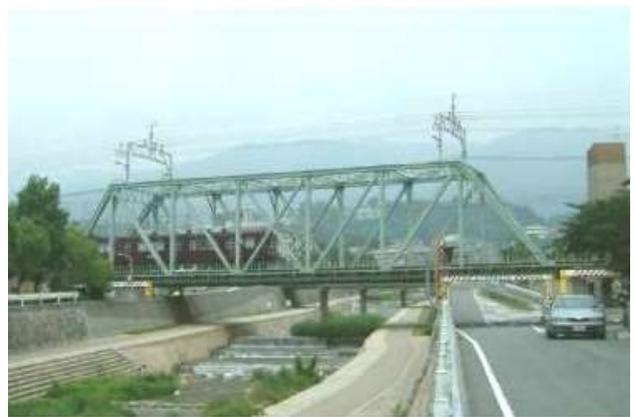
KJK126.住吉川橋梁(兵庫 1934/1926)(阪急電鉄神戸線)神戸市東灘区(住吉川)大阪駅東海道線跨線線路橋. 1934年撤去, のち, 本橋と宝塚線国道176号架道橋に転用
