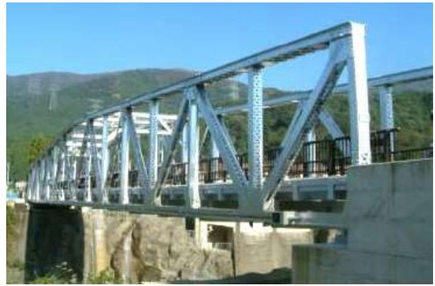
KJK187.金名橋(2004/1951)(手取キャニオン自転車道)石川県白山市鶴来-鳥越(手取川)金沢市内の御影大橋(3径間ワレントラス)のトラス部材を利用して、1連の単純トラスに再生
