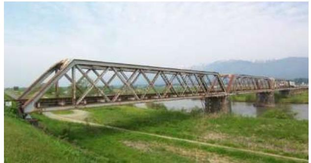
KJK114.最上川橋梁③(山形鉄道フラワー長井線)(1923/1886)山形県白鷹町(最上川)英パテントシャフト製・東海道本線木曾川橋梁 OR 長良川橋梁, 支間短縮して移設再利用
