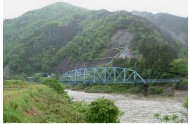
KJK154.第五長良川橋梁(1960/1911)(長良川鉄道越美南線)岐阜県郡上市八幡町(長良川)米 AcB 製・東海道本線木曾川橋梁・シュウエドラトラス形式を移設
