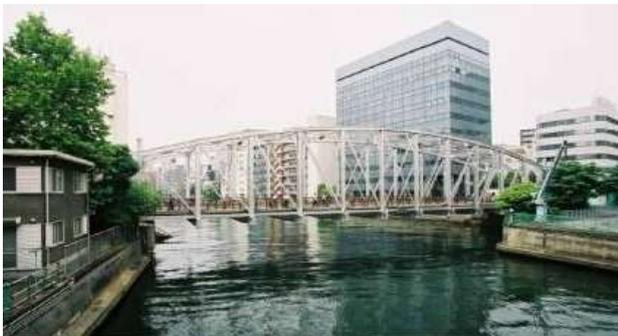
KJK125.南高橋(東京 1932/1904)(区道)東京都中央区(亀島川)1932年 1904年 HH 隅田川両国橋, 1932年両国橋3連の中央径間を移設(幅員を狭め、一部補強のため改造)
