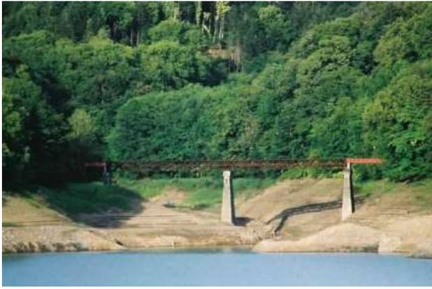
KJK147.第五号橋梁(1958/1933)(大夕張森林鉄道)北海道夕張市(シュウパロ湖)旧陸軍の重構桁鉄道橋(全溶接ユニットによる可搬組立橋)を利用(6号橋も同様)
