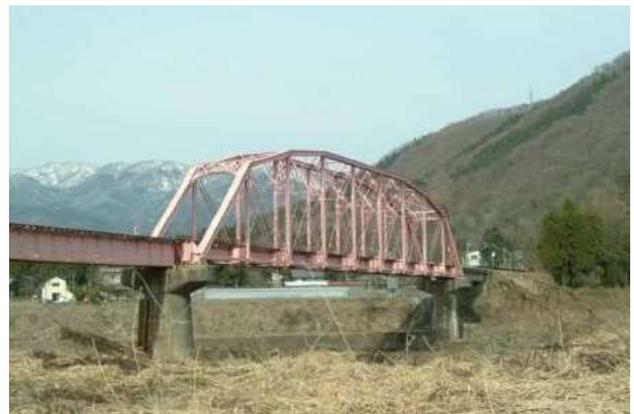
KJK158.第一九頭竜川橋梁(1962/1911)(JR 越美北線)福井県大野市(九頭竜川)米 AcB 製・東海道本線大井川橋梁・シュウエドラトラス形式
