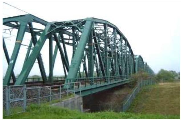
KJK166.天竜川橋梁(1969/1915)(JR 東海道本線下り線)静岡県磐田市豊田-浜松市(天竜川)1969年旧上り線橋梁(プラットラス)を横移動して下り線に再利用, 上り線橋梁は新設
