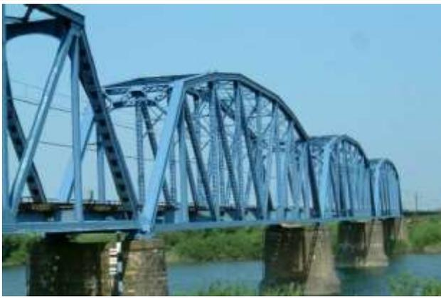
KJK159.阿賀野川橋梁(1963/1916)(JR 羽越本線)新潟県新津市(阿賀野川)常磐線利根川橋梁(3連分)を移設, 庄川橋梁(60), 第二高原川橋梁(64)と姉妹橋
