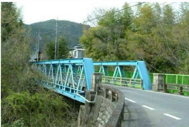
KJK139.油皆洞橋(1954/1913)(旧国道 418 号)岐阜県八百津町(油皆洞川)HR100ftトラスを支間はそのまま・幅員縮小
