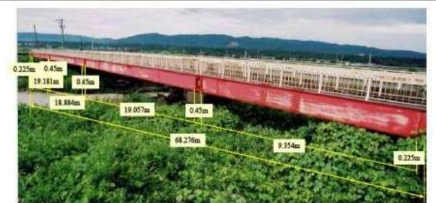
KJK170. 下青川橋側道橋(市道)(データなし)三重県いなべ市(青川)上路鋼プレートガーダー,桑名市内員弁川桑部橋側道橋(6@23.5m)として架設. 1984年大改造をして, 現在地に移設し, 側道橋とした. 23.5m 支間長の単純鋼床版版桁 3 連を各々切断・連結し, 支間長を変え, 4 径間として再利用している.学童の通学路
