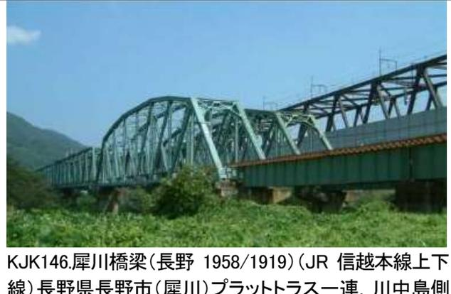
KJK146.犀川橋梁(長野 1958/1919)(JR 信越本線上下線)長野県長野市(犀川)プラットトラス一連、川中島側の鋸桁(1920年頃製作)はすべて再利用
