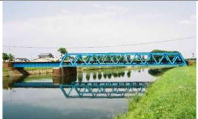
KJK104.五行川橋梁(1913/1894)(真岡鉄道)栃木県真岡町(五行川)前架設箇所不明, 1948 年溶接補強
