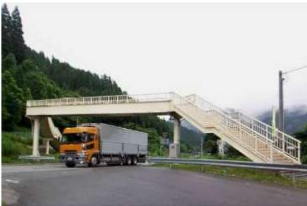
KJK188.熊波横断歩道橋(2003/1960?)熊波横断歩道橋,一本柳交差点の改良工事に伴い、撤去された歩道橋の一部を用いて、工場にて改造し、現在地に移設
