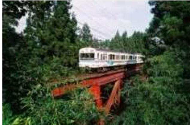
KJK122 押手沢橋梁(秩父鉄道)埼玉県秩父市荒川(押手沢),(1930/1913),パルチモア・トラスは中央線や山陰線に17連輸入架設されたが,このほか,一ノ戸橋橋梁・蟹沢橋梁(磐越西線),4連が現存.
