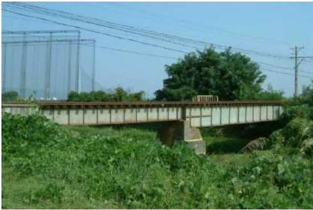
KJK113.鮎川橋梁(1922/1897)(長野電鉄屋代線)長野県須坂市(鮎川)ClevelandBridge 作 30 年式 80ft 桁の支間短縮
