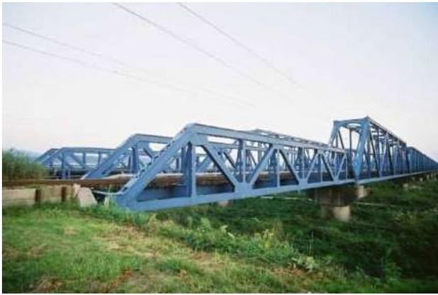
KJK155.第二最上川橋梁(1960/1920)(JR 羽越線)山形県酒田市-庄内町(最上川)下り線 12 連目・上り線 13 連目の 100ft ポニートラスは転用・前架設箇所不明
