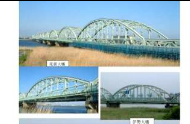
KJK040, 尾張大橋, 愛知県弥富市—三重県桑名市, 木曾川, 国道 1 号, 1933, 1963 年歩道添加 (幅員 2x1.5 m), 鋼橋集覧 A5-038, 1934 年同種のランガートラス橋伊勢大橋 (15x72m) が完成し、国道全通。(桑名市、揖斐川長良川)
