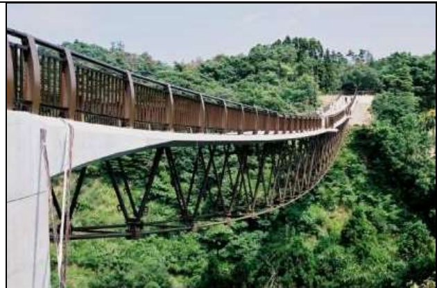
KJK072、森のわくわく橋、福島県いわき市(いわき公園)、2001、吊床版橋、支間 128.5、幅員 3
