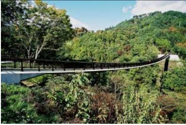
KJK077、グリーンパーク橋、長野県生坂村草尾(グリーンパーク)、1998、吊床版橋、支間 94.2、幅員 1.5
