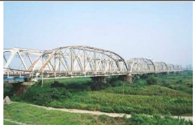
KJK016, 新神通川橋梁, 富山県富山市, 神通川, JR 高山線, 1908、アメリカン・ブリッジ製の 200ftトラス(ピン結合), 鋼橋集覧 T10-036
