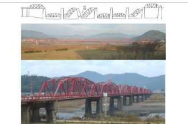
KJK028, 四万十川橋, 高知県四万十市(四万十川) 県道 346号, 1926, RC部はあとで延長。1946年12月南海大地震によりトラス8連中6連が落橋。4連は補修して最架設。2連は新設, 1968年歩道部添加(幅2m), 鋼橋集覧 T8-010
