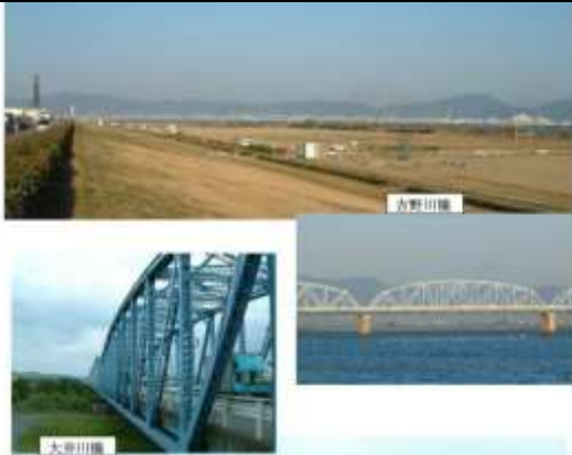
KJK031, 吉野川橋, 徳島県徳島市,吉野川,県道 39号,1928,鋼橋集覧 T9-049,1071mの橋長は当時東洋一, 同年, 先に大井川橋が 1kmを越えたが、数ヶ月後に吉野川橋が完成,1965年両側に幅員 2mの歩道部添加。
