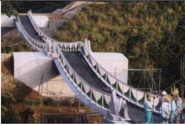
KJK089、ツウタ橋(2径間連続)、千葉県君津市(片倉ダム・笹川湖)、1999、吊床版橋、支間 62+26、幅員 2.5
