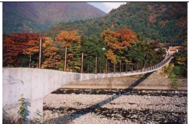
KJK076、दैあい橋、岐阜県白川村荻町(白川郷・庄川)、1993、吊床版橋、支間 97、幅員 1.5
