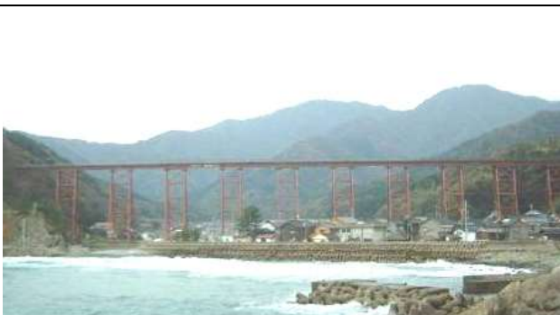
KJK021, 旧余部橋梁,兵庫県市香住町,長谷川,山陰本線,1912,1986 年列車転落事故発生,2010 年新余部橋梁(PC ラーメン橋), 鋼橋集覧 G4-003)
