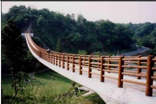
KJK073、陣屋の森吊橋、大分県由布市挾間町(陣屋の村)、1993、吊床版橋、支間 123、幅員 1.5
