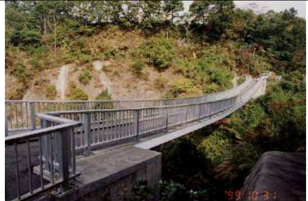
KJK084、片倉ダム林道5号橋、千葉県君津市(片倉ダム・笹川湖)1996、吊床版橋、支間 51、幅員 2
