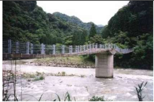
KJK090、双龍橋(2径間連続)、宮崎県日南市(広渡川)、蜂の巣キャンプ場、1984、吊床版橋、支間 36.5+36.5、幅員 1
