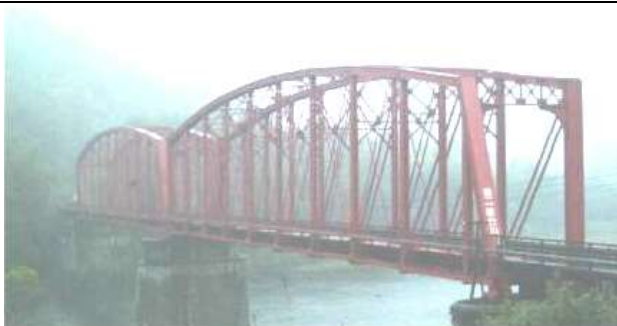
KJK013, 遠登志橋, 愛媛県新居浜立川町大永山, 国領川支流の小女郎川, 1905, 現存する鋼アーチ橋では国内で最古, 1993 年鋼アーチ橋を保存するためにアーチ部の床組をはずし、上に独立して歩行者用吊橋を建設, 鋼橋集覧 A3-003)
