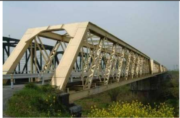
KJK002, 揖斐川橋, 岐阜県瑞穂市—大垣市,揖斐川, 歩道橋,(1913/1887) 東海道線建設初期の 200ft トラス。原位置で道路橋に転用。鋼橋集覧 T3-006
