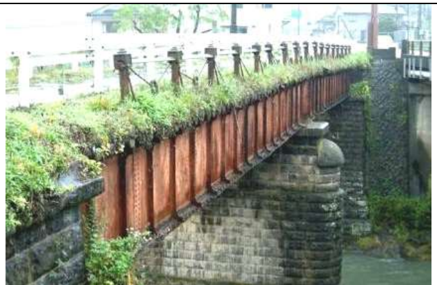
KJK010, 明治橋, 大分県臼杵市野津町,野津川,国道10号,1902, 1961年上流側に新明治橋が完成して、歩行者専用橋に転用,鋼橋集覧 G5-004
