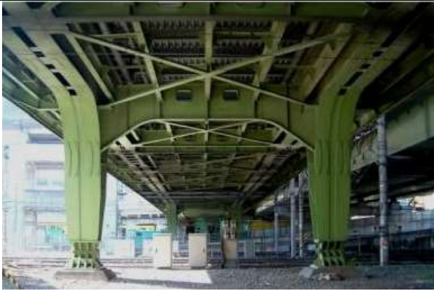
KJK035, 田端大橋, 東京都北区田端, 跨線人道橋 (JR 田端駅と山手線・東北本線), 1935、鋼橋集覧 G7-026、わが国最初の大形全溶接全溶接π形ラーメン。
