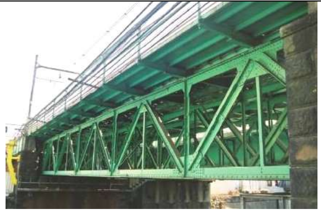
KJK012, 小石川橋通架道橋, 東京都千代田区,日本橋川, JR 中央本線緩行上下線, 1904 年、ハーコート製のトラス,鋼橋集覧 T1-007)
