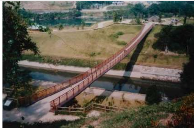
KJK082、縄文橋、熊本県和水町(江田川水辺公園)、1994、吊床版橋、支間 76.5、幅員 2
