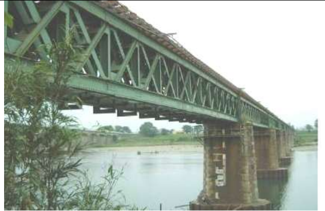
KJK008, 宮川橋梁, 三重県伊勢市,宮川,JR参宮線, 1897, 第2次世界大戦中2連と戦後に9連、ダブルワーレントラスに補強,鋼橋集覧 T1-004
