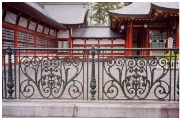
KJK055、旭川北海道護国神社・本殿前の鉄柵 1888 年完成の旧二重橋の高欄を 1963 年現二重橋への架替え時にお下げ渡し(移設再利用)した。
