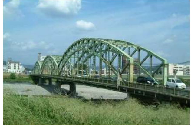
KJK036, 中橋, 栃木県足利市, 渡良瀬川, 県道 116 号, 1936, ブレースドリブタイドアーチ, 鋼橋集覧 A5-054
