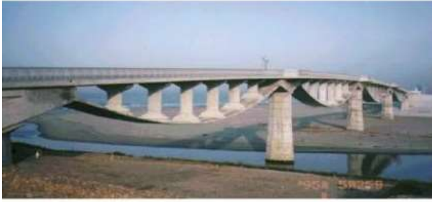
KJK095、しおさい橋(4径間連続)、静岡県掛川市国安(太平洋自転車道・菊川)、1995、吊床版橋、支間55+61+61+55、幅員3
