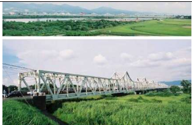
KJK034, 長生橋, 新潟県長岡市,信濃川,国道 351号,1934, ゲルバートラス, 橋長 850.8m・7.0m(車道 16.60m+歩道 2x2.70m) 支間 67.5m+11x65.0m+67.5m (鋼橋集覧 T9-026)
