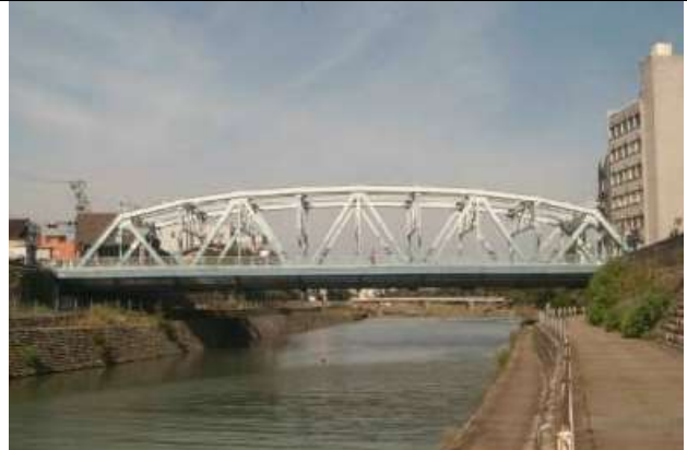
KJK026, 犀川大橋, 石川県金沢市, 犀川, 国道 157号, 1924, 道路橋では国内最初のワーレントラス。1966年まで市街電車と共用, 以後、道路専用, 1994年改修補強。歩道部拡幅。鋼橋集覧 T8-006
