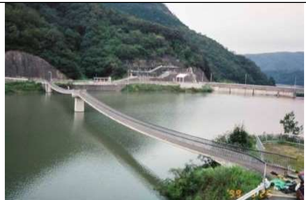
KJK088、香下ダム吊橋(2径間連続)、大分県宇佐市、1995、吊床版橋、支間 62.5+62.5、1.5
