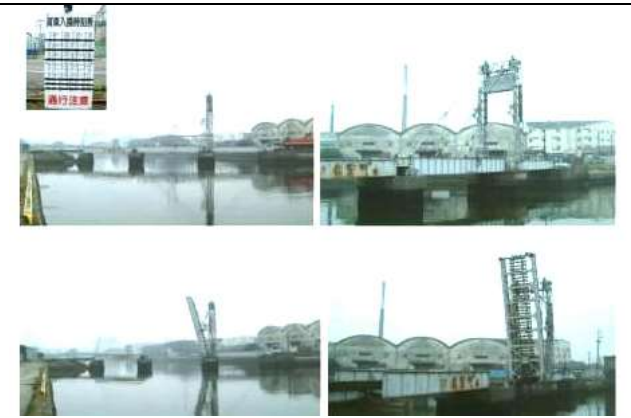
KJK038, 末広橋梁, 三重県四日市市 (千歳運河) 関西本線四日市駅構内引込線, 1931 現在も、時刻表により定時跳開あり。(鋼橋集覧 M3-016)
