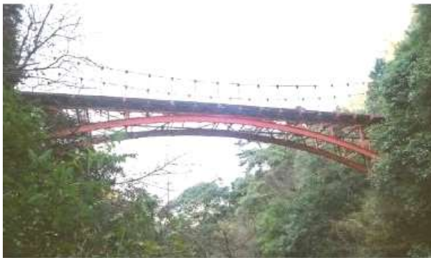
KJK013, 遠登志橋, 愛媛県新居浜立川町大永山, 国領川支流の小女郎川, 1905, 現存する鋼アーチ橋では国内で最古, 1993 年鋼アーチ橋を保存するためにアーチ部の床組をはずし、上に独立して歩行者用吊橋を建設, 鋼橋集覧 A3-003)
