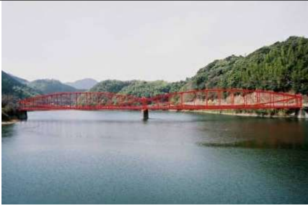
KJK029, 南河内橋, 福岡県北九州市八幡東区,板櫃川河内貯水池,1927年,鋼橋集覧 T6-002, 形式下路レンズ形トラス(レンティキュラートラス、ピン結合, 橋長・幅員 132.97m・3.06m,支間 2x66.0m
