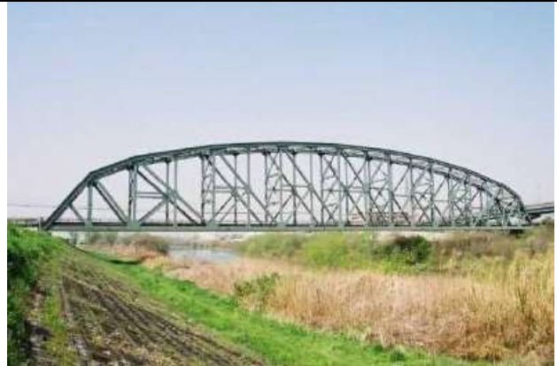
KJK032, 澱川橋梁, 京都府京都市伏見区,淀川,近鉄・京都線,1928,鋼橋集覧 T5-013, 複線下路プラット分格トラス(ペンシルベニアトラス)橋長 162.4m,支間 164.6m (540ft)
