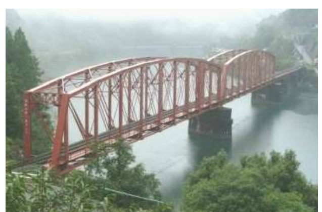
KJK014, 第一球磨川橋梁, 熊本県坂本村、球磨川, 1908 年、アメリカン・ブリッジ製の 200ftトラス(ピン結合), 鋼橋集覧 T1-008,9)
