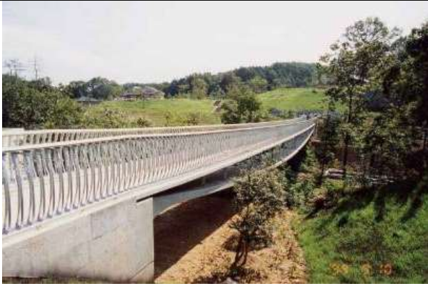
KJK083、夢つり橋、石川県能美市(いしかわ動物園内)、1999、吊床版橋、支間 55、幅員 2
