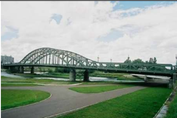
KJK039, 旭橋, 北海道旭川市, 石狩川, 国道 40 号 1932, ブレースドリブバランスドタイドアーチ, 橋長・幅員 225.43m・18.289m (車道 12.802m + 歩道 2x2.743m) 支間アーチ部 51.130m + 91.440m + 51.130m、鋼橋集覧 A5-032,
