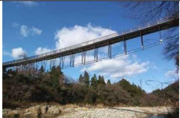
KJK080、大巻どんど橋、石川県白山市鳥越-吉野(手取川)、2009、吊床版橋、支間 82、幅員 2
