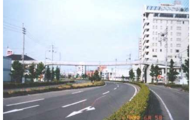
KJK094、宇多津歩道橋(3径間連続)、香川県多度津町(国道)、1991、吊床版橋、支間 16.5+35+16.5、幅員 3
