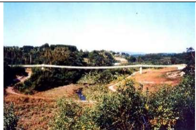
KJK092、とんぼの橋(3径間連続)、宮崎県高鍋町(高鍋防災ダム)、1996、吊床版橋、支間 30+80+30、幅員 1.5
