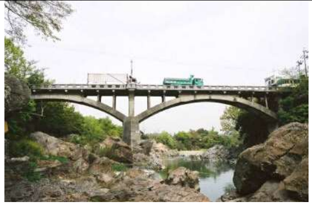
KJK018, 鹿乗橋, 愛知県春日井市—瀬戸市,庄内川, 県道,1910,明治期の元鋼アーチ道路橋,1948 年損傷したアーチ鉄骨をコンクリートで巻立て補強,鋼橋集覧 A3-005
