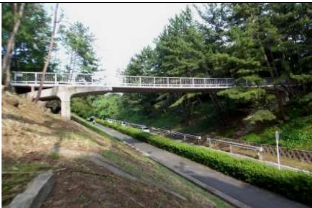
KJK087、万博9号橋、大阪府吹田市(万博公園西ゲート)、1969、吊床版橋、支間 21、5
