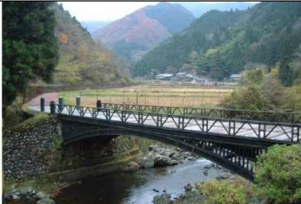
KJK001, 神子畑橋, 兵庫県朝来市, 神子畑川、歩道橋、(1982/1885), 元鉱石運搬路・神来軌道(神子畑—生野間馬車鉄道、他に羽淵橋など 4 橋の鑄鉄橋建設,鋼橋集覧 A3-001, 1977 年重要文化財
