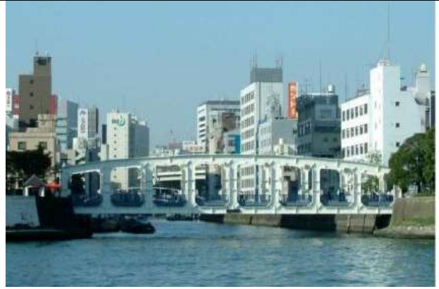
KJK030, 豊海橋, 東京都中央区箱崎-新川,日本橋川,1927,鋼橋集覧 T9-049, 下路フィーレンデール
