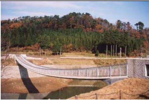
KJK081、滝波ふれあい橋、福井県福井市(滝波ダム湖)、1995、吊床版橋、支間 79、2.5
