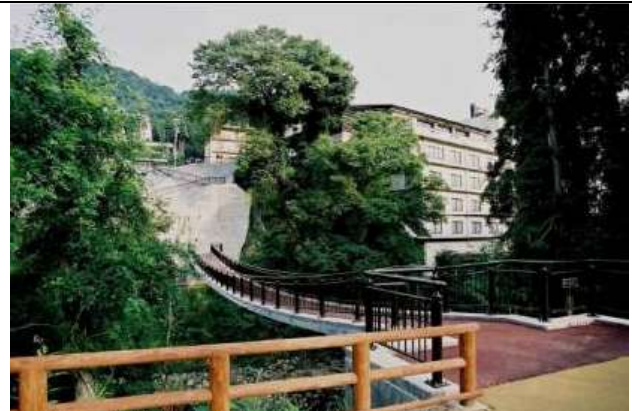
KJK086、かじか橋、石川県加賀市山中温泉(大聖寺川)、1999、吊床版橋、支間 39、幅員 2
