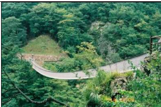
KJK075、梅の木轟公園吊橋、熊本県八代市五家荘(五木川)、1989、吊床版橋、支間 105、幅員 1.3
