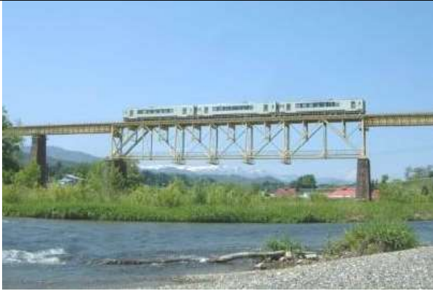
KJK017, 一ノ戸川橋梁, 福島県山都町,一ノ戸川, JR 磐越西線,1910、クーパーによる標準設計の 200ft 上路トラス(ピン結合),鋼橋集覧 T1-011)
