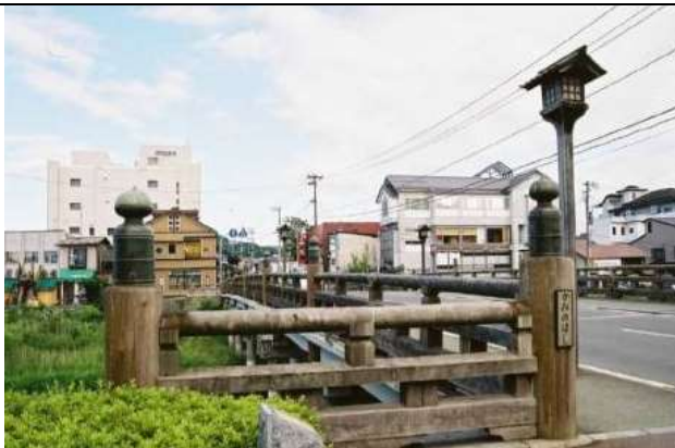
KJK056、上の橋、盛岡市中津川、(現橋は 1935 年架設)、1609 年建設時より擬宝珠何度も流出するが残存 18 個を再利用した。
