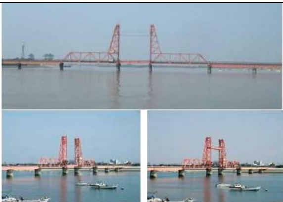
KJK033, 筑後川橋梁, 佐賀県佐賀市諸富町-福岡県大川市,筑後川, 昇開式可動橋(ワーレントラスとプレートガーダー)元 JR 佐賀線,1935年架設。1987年佐賀線廃線,1996年から遊歩道(動態保存、定時昇開), 鋼橋集覧 M3-027
