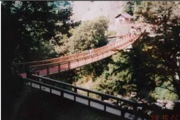
KJK085、あじさい橋、佐賀県唐津市(伊岐佐川・見帰りの滝)、1993、吊床版橋、支間 45、幅員 2
