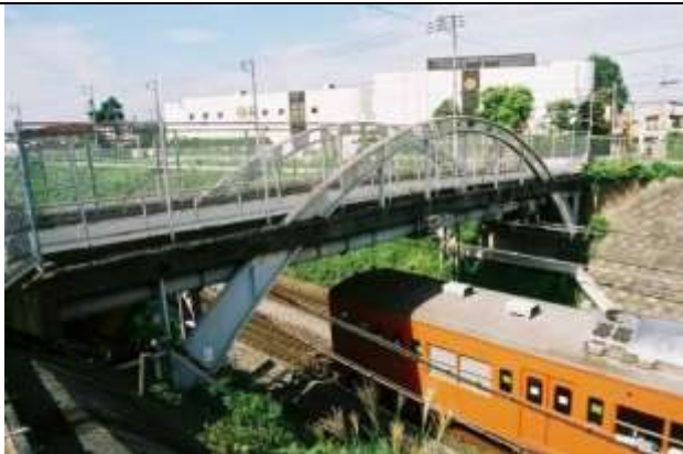
KJK052、第一跨線道路橋、東京都立川市 JR 中央本線立川駅西 1km 1935 年、古いレール材を用いた橋梁の例。飛鳥山跨線橋(KJK027)も参照
