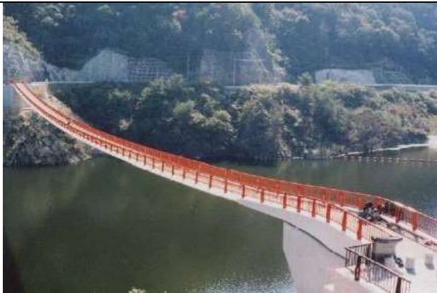
KJK071、夢吊橋、広島県、府中市一世羅町(八田原ダム湖)、1996、吊床版橋、支間 147.6、幅員 2.5
