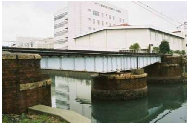
KJK065、和田岬線・和田旋回橋(1900 年)
