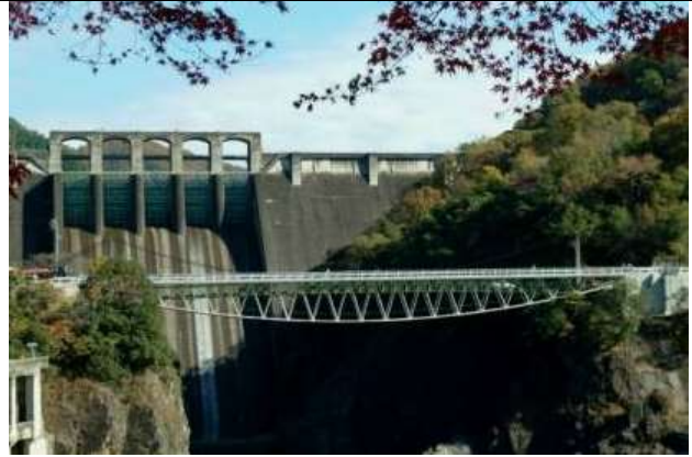
KJK078、のぞみ橋(県道)、岐阜県八百津町-御嵩町(木曾川)、2003、吊床版橋、支間 90、幅員 4
