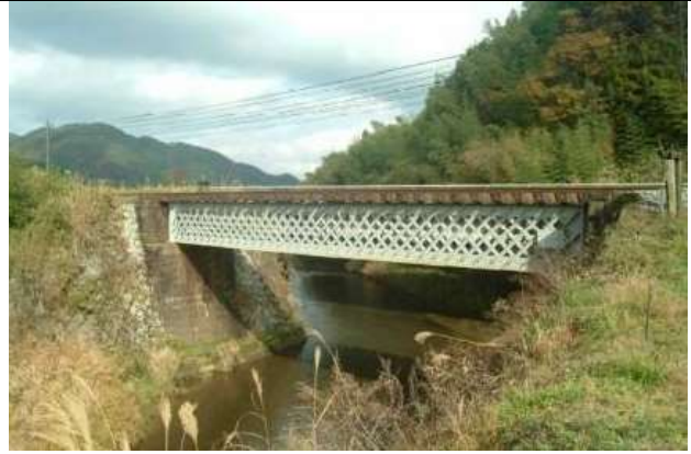
KJK024, 徳佐川橋梁, 山口県山口市, 沖田川, 山口線, 1922, 当時、大形鋼板が入手困難となり、桁腹部を山形鋼で組んで、ラチス桁とした。同様のラチス桁は山陰本線に以下の2橋が現存している。竹野川橋梁、田君川橋梁、鋼橋集覧 G2-011
