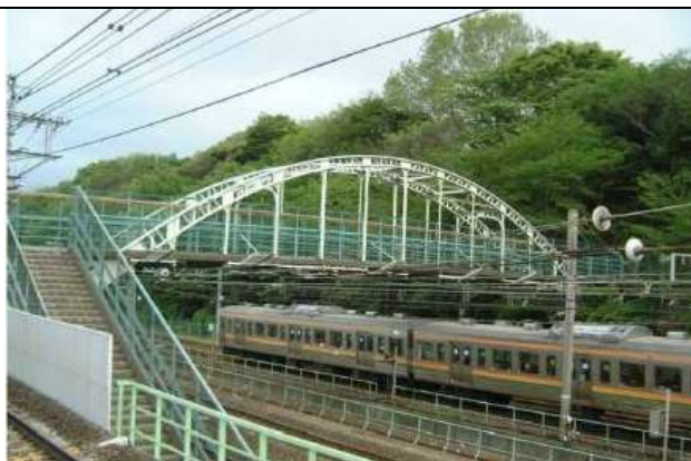
KJK027, 飛鳥山下跨線人道橋, 東京都北区, JR 東北本線, 1925, 鋼橋集覧 A4-006, 古レールによるリサイクル橋は、1935年架設、第一跨線橋(立川市、JR中央線)が現存,
