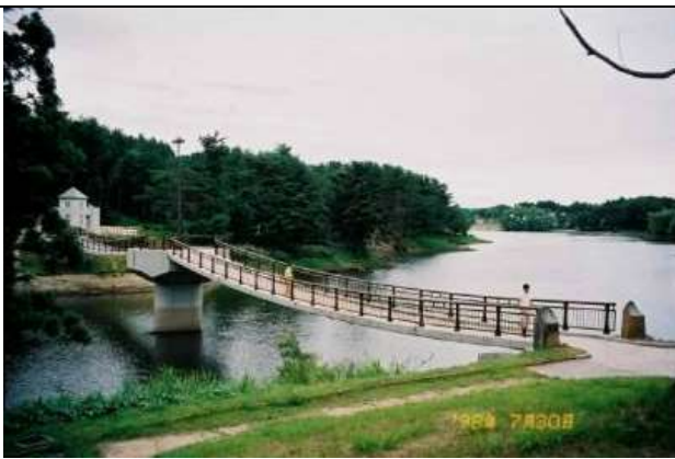
KJK091、みかえり橋(2径間連続)、青森県青森市(野木和公園)、1993、吊床版橋、支間 35+35、幅員 2.5
