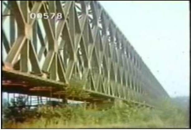
578、KRNT000715、不明橋、YU、ベルグラード、セルビア、ほぼ全景を撮影、鉄道橋、トリプルワーレン・トラス橋、1986????
