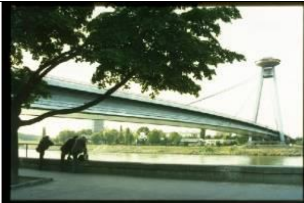
KRS086、プラスチラバ橋、SK、スロヴァキア、プラスチラバ、鋼斜張橋、1972、303m、塔上にレストランあり
