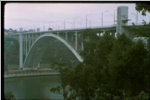
KRS040、アラビダ橋、PT、ポルト、RC アーチ、1964、 270m、世界8位
