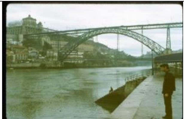
KRS048、ドン I 世橋、PT、ポルト、鋼アーチ、1886、 173m、エッフェルの弟子の設計、二階橋
