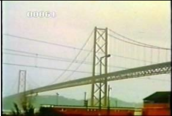
61、KRNSF10507、4月25日橋、PT、リスボン、斜め 全景、吊橋
