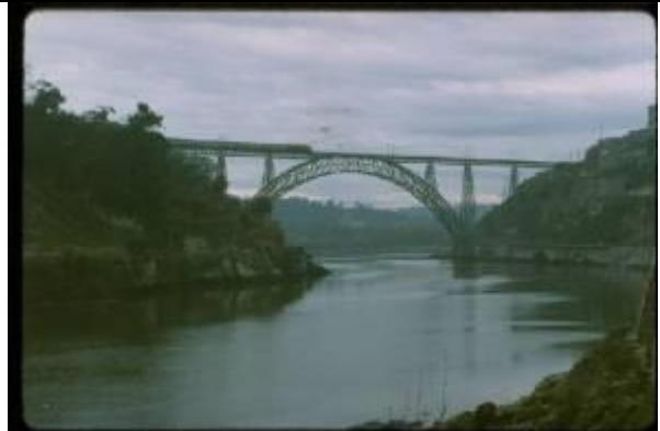
KRS050、マリアピア橋、PT、ポルト、鋼2ヒンジアー チ、1877、160m、エッフェルの製作
