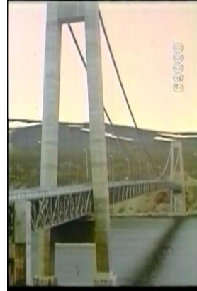
69、KRNSF10215、クバルズンド橋、NO、橋たもと附近から撮影した斜めからの全景、塔はPC製、トラスの補剛桁、70度30分、最北の吊橋、1990????
