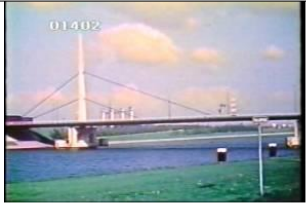
1402、KRNC000603、ハームセン橋、NL、47+108 m、1968年建設?、全溶接、オランダの小斜張橋、197205??
