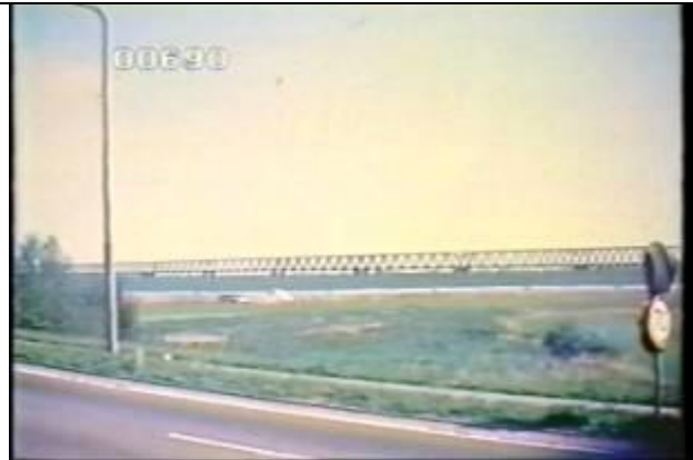
690、KRNT000706、不明橋、NL、遠景、トラス橋、19720500
