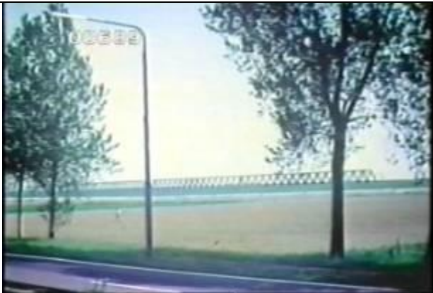
689、KRNT000707、不明橋、NL、遠景、トラス橋、19720500
