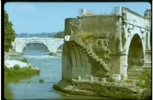
KRS005、ポンテロット橋、IT、ローマ、石造アーチ、179BC、端径間を残すのみ
