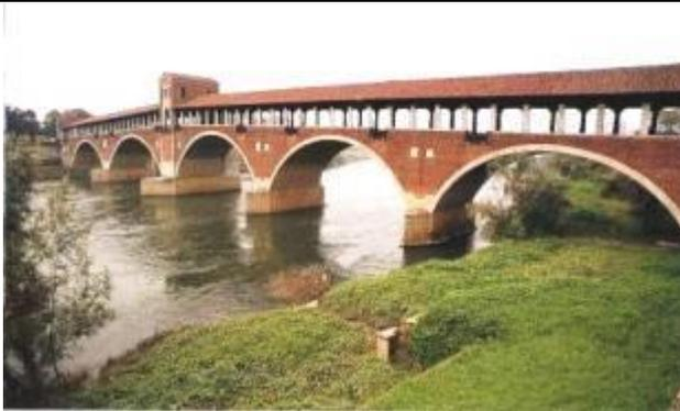
コベルト橋、古くからティチーノ河に架かっていた屋根付きの橋。14 世紀の中頃、現在のスタイルになった。第二次世界大戦のとき空爆で破壊され、戦後再建された。
