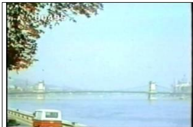
495、KRNSF01118、不明橋、HU、遠景、吊橋、19860000
