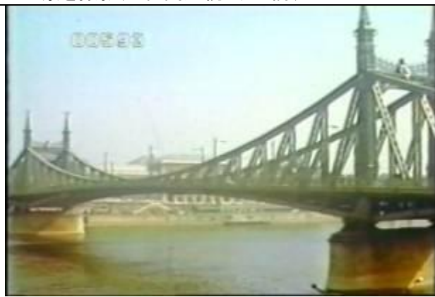
593、KRNT000519、不明橋、HU、ブダペスト、斜めからほぼ全景を撮影、トラス橋、19860000
