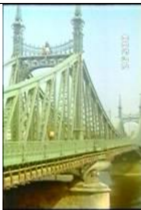
592、KRNT000518、不明橋、HU、ブダペスト、斜めからほぼ全景を撮影、トラス橋、19860000
