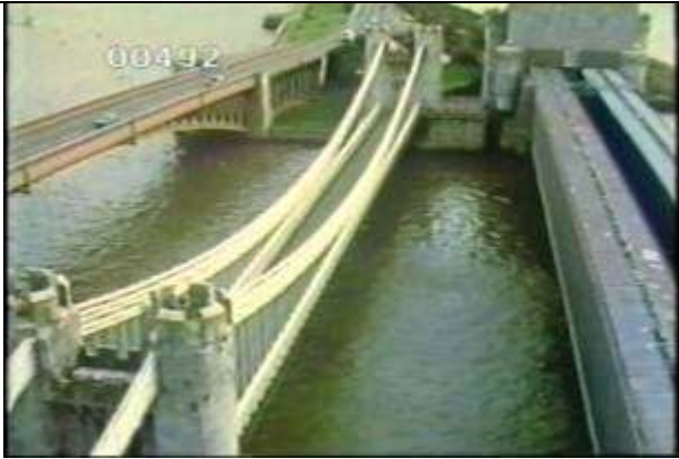
492、YMD0871704、コンウェイの吊橋、GB、中央が吊橋、左が道路橋(アーチ)、右が鉄道橋(チューブ)、198704??
