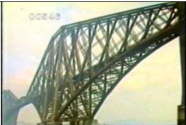
546、KRNT000112、フォース橋、GB、斜めからほぼ全景を撮影、トラス橋、
