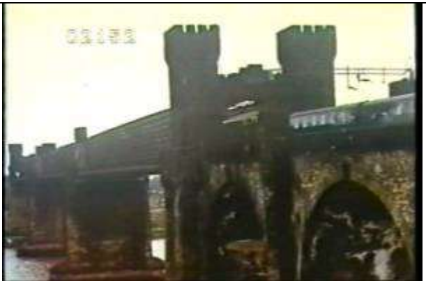
2152、KRNT000713、不明橋、GB、ロンドン、ロンドンーウエスタン鉄道、斜めから全景を撮影、ロンドンーウエスタン鉄道、1868年
