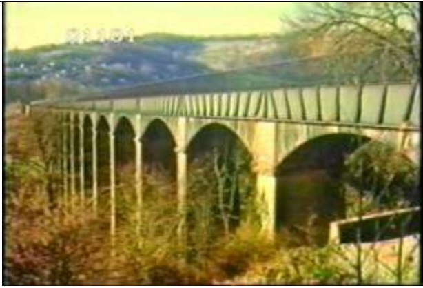
1101、YMD0871807、Pontcysllte橋、GB、鑄鉄の水 路橋、198704??
