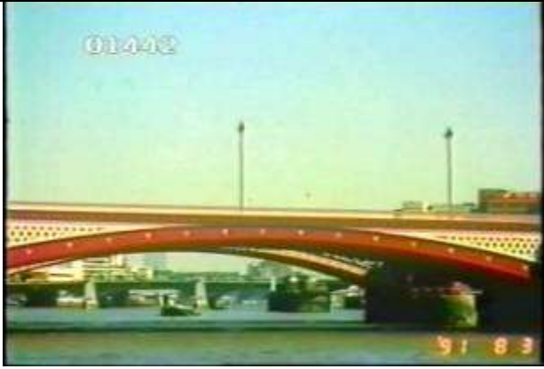
1442、SOMK000083、ブラックファイヤー橋、GB、ロンドン、テムズ川、スパンのみ写す、19910831
