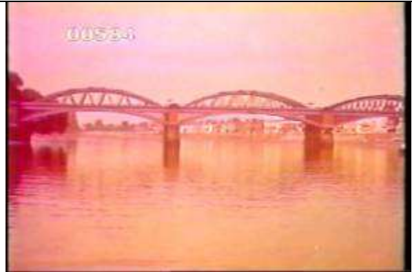
584、KRNT000318、不明橋、GB、ロンドン、橋のほぼ全景を撮影、遠景、イギリス、トラス橋
