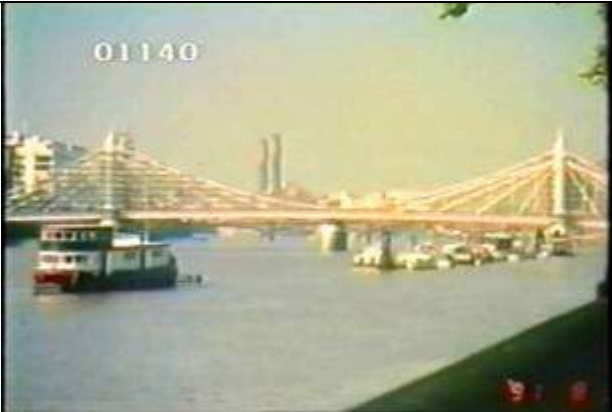
1140、SOMK000091、アルバート橋、ロンドン、テムズ川、塗装中、19910830
