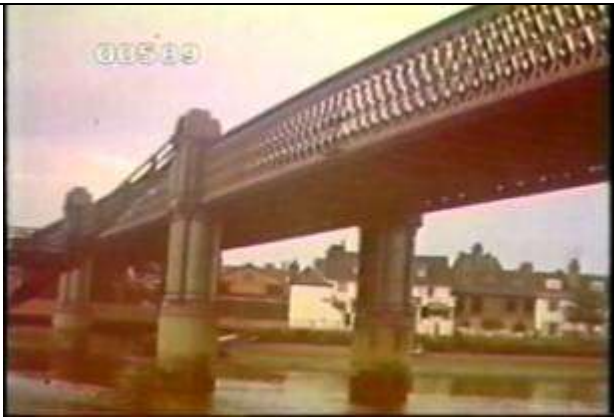
589、KRNT000210、不明橋、GB、ロンドン、斜めからほぼ全景、トラス橋、
