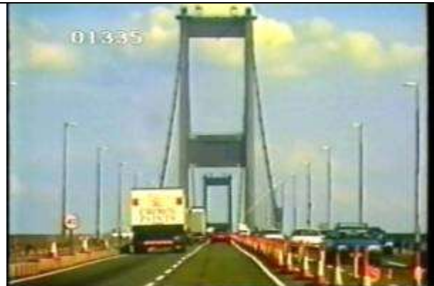
1335、SOMK000073、セバーン橋、GB、橋上、タワーを写す、19910828
