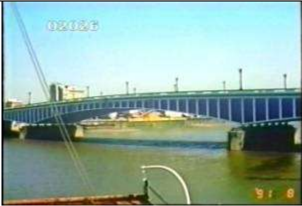
2026、SOMK000094、不明橋、GB、ロンドン、ロンドン、テムズ川、ほぼ全景、(バターシア橋の重流に位置)、19910830
