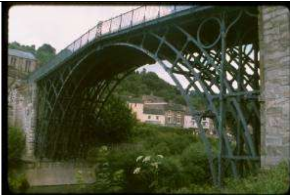
KRS044、アイアン橋、GB、鑄鉄アーチ、1779、24m、最初の鉄の橋、セヴァーン川上流に鉄鋼王 Daby I の孫により架設
