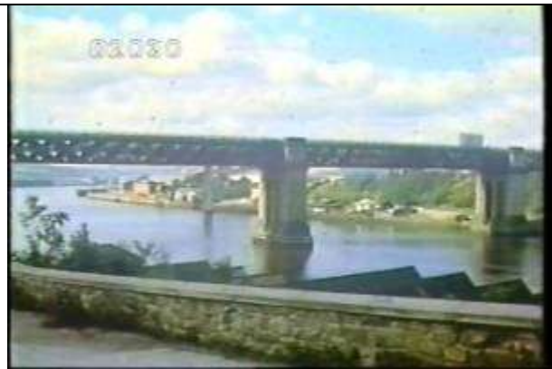
2030、KRNT000714、エドワード7世鉄道橋、GB、マンチェスター、アーウェン川、ほぼ全景を撮影、ニューカッスル、ラチストラス橋、1906年建設、
