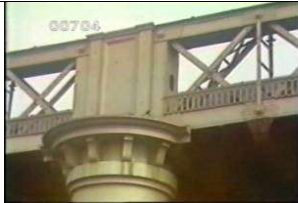
704、KRNT000209、不明橋、GB、ロンドン、橋脚とトラス桁との接合部、トラス橋、
