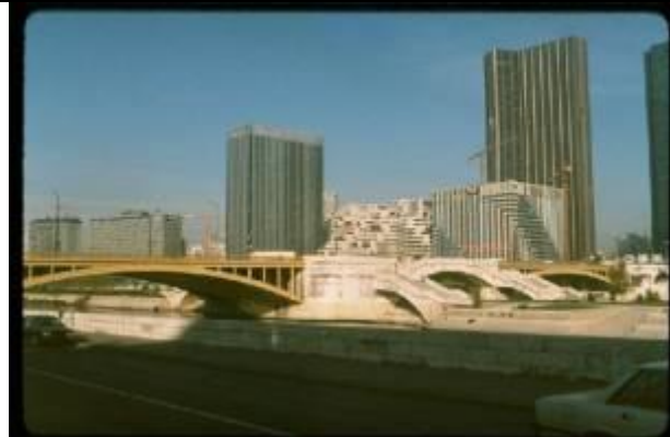
KRS031、ニューイ橋、FR、パリ、鋼アーチ、戦後旧橋に替わり全溶接鋼アーチとして建設
