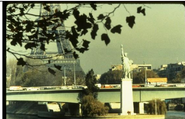
KRS027、グレネル橋、FR、パリ、3径間鋼連続桁、1968、横に自由の女神のレプリカがアメリカにより寄贈されて立っている
