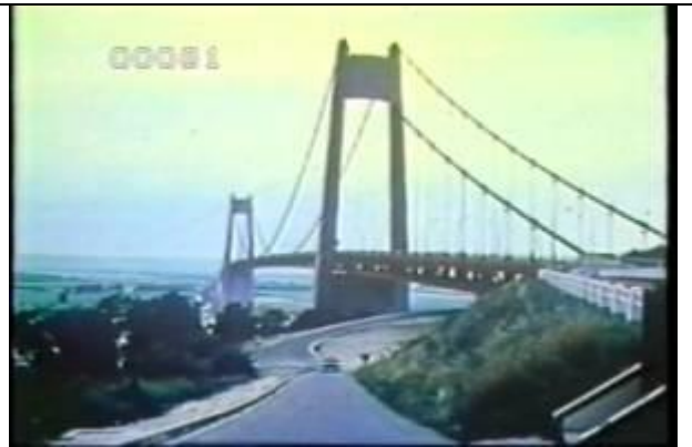
81、KRNSF10602、タンカービレ橋、FR、斜め全景、フランス、吊橋、
