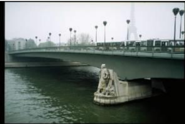
KRS028、アルマ橋、FR、パリ、3径間鋼連続桁、1974、110+31.5m、アルジェ兵士はセーヌ川の水位計 (図は左右入れ違いか?)
