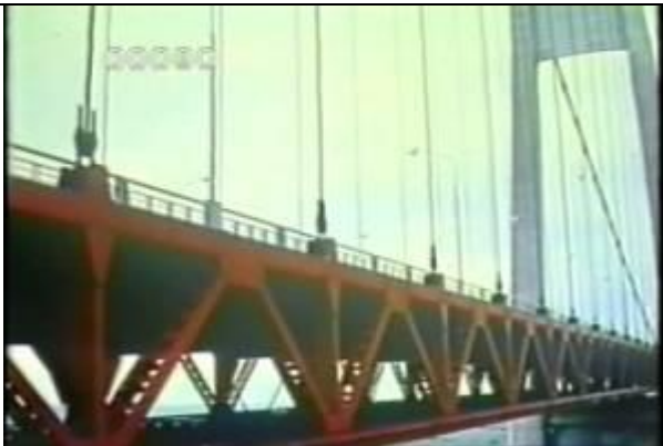
80、KRNSF10605、タンカービレ橋、FR、橋のたもと附近からの全景、吊橋、
