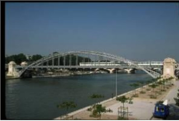
KRS029、オステルリッツ橋、FR、パリ、鑄鉄アーチ、1905 補修完、橋長 240m、ナポレオンの戦勝地を記念して、地下鉄橋
