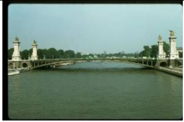
KRS026、アレキサンダー三世橋、FR、パリ、鑄鋼アーチ、1890、橋長 107.5m、ロシア皇帝ニコライ二世の万博のために寄贈
