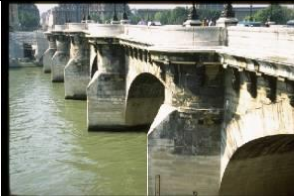
KRS021、ヌフ(新)橋、FR、パリ、石造アーチ、1591、橋長 229m、パリ最古の橋
