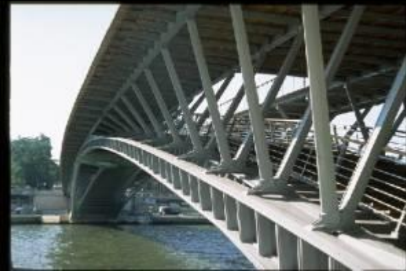
KRS034、ソルベリノ橋、FR、パリ、フィーレンデールリブアーチ、2000、“デザインコンクールにより選ばれたが、振動が多く改修された”
