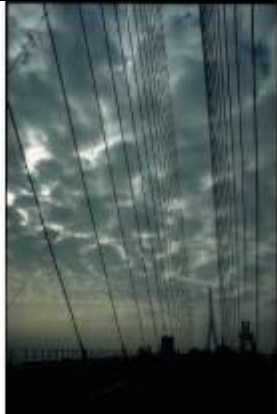
KRS090、ノルマンジー橋、FR、ノルマンジー、PC 塔を持つ斜張橋、1995、856m、世界第2位の斜張橋
