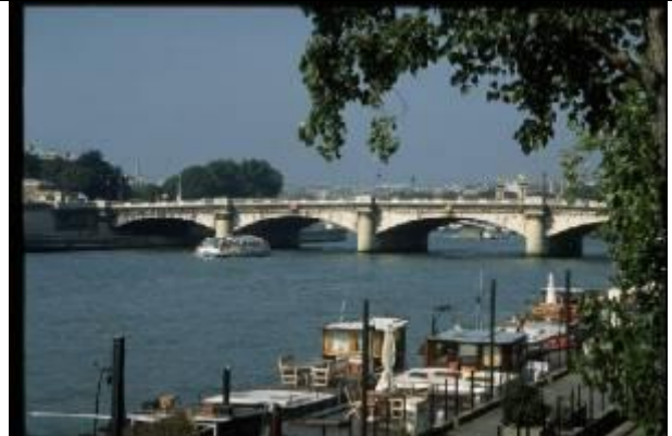
KRS024、コンコルト橋、FR、パリ、石造アーチ、1791、橋長 153m、ペロネにより近代力学によって設計された
