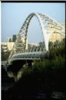
KRS032、クレテユ歩道橋、FR、パリ、ニールセン橋、1988、カルトラバ氏の設計、生物の骨格を思わせる
