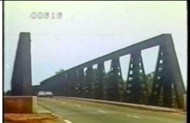
616、KRNT000717、不明橋、FR、入口付近で斜めにほぼ全景を撮影、フランス、トラス橋
