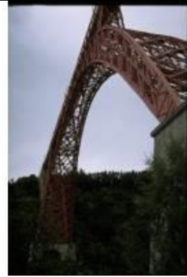
KRS051、ギャラビー橋、FR、サンフレール、鋼2ヒンジアーチ、1877、橋長 564m、エッフェルの製作、エッフェル塔は立った橋
