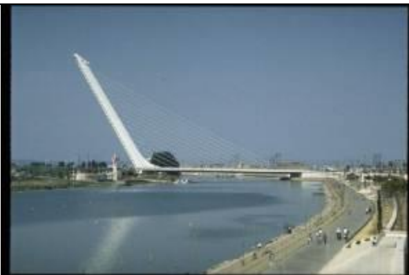
KRS089、ルミタニヤ橋、ES、セルビア、複合斜張橋、1992、195m、58 度傾いた PC 塔が自重で桁を吊り上げている、カラトラバ氏の設計
