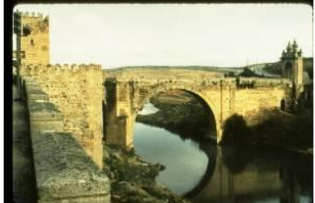
KRS011、アルcantアラ橋、ES、トレド、石造アーチ、(98)871-、27.8-29.7m、サラセン文化の影響
