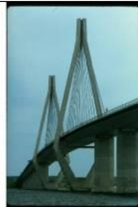
KRS087、ファロ橋、DK、コペンハーゲン、斜張橋、1985、290m、桁内部の防食のために乾燥空気を強制通風
