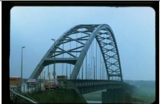
KRS063、デュイスブルグ橋、DE、デュイスブルグ、ランガー形式、1950、225.1m、世界最長のランガー桁
