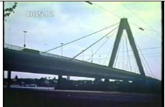
512、KRNC000111、ゼベリン橋、DE、ケルン、ライン 河、斜めからの全景、斜張橋、19631000
