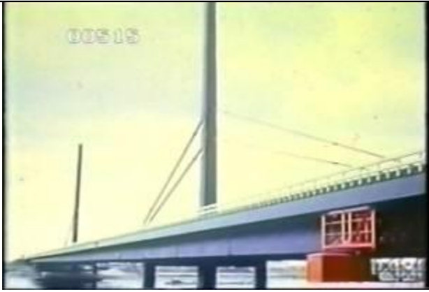
515、KRNC000115、ノルトエルベ橋、DE、ハンブルク、斜めからの全景、斜張橋、19631000
