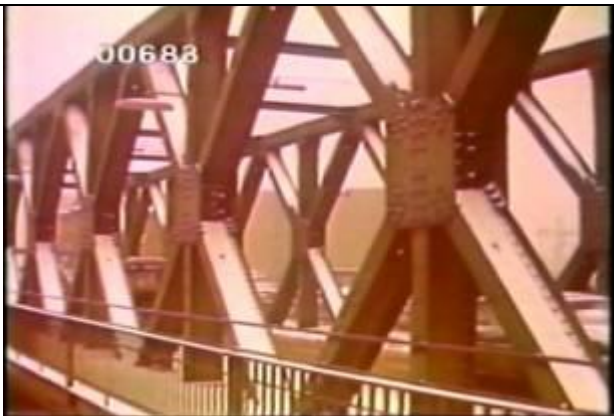
683、KRNT000202、不明橋、DE、ハンブルク、トラス構造と高欄の近接撮影、トラス橋
