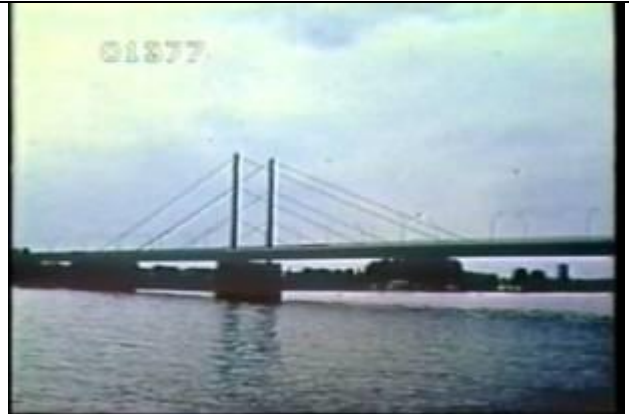
1377、KRNC000103、テオドール・ホイス橋、DE、デュッセルドルフ、ライン河、片側半分の遠景、斜張橋、19631000
