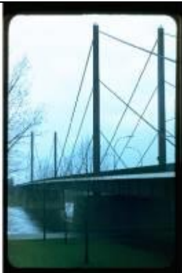
KRS085、テオドールホイイス橋、DE、ケルン、鋼斜張橋、1957、260m、最初の斜張橋の一つ
