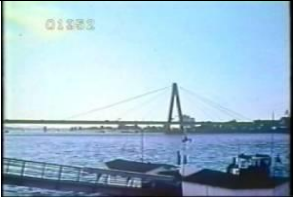
1352、KRNC000112、ゼベリン橋、DE、ケルン、ライン河、遠景、全景、斜張橋、19631000
