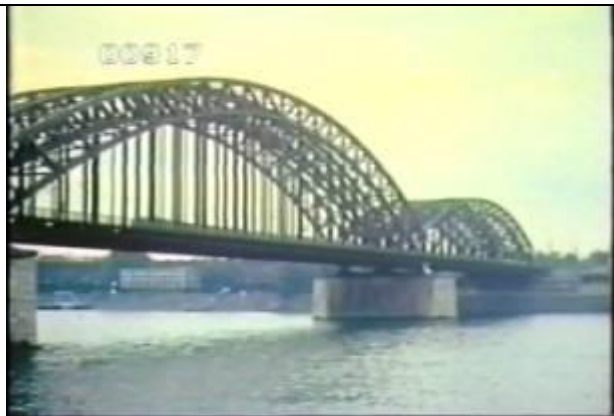
917、MTGD000021、不明橋、DE、ケルン、全景、斜めからの撮影、アーチ橋、組合わせ部材を使用、鉄道橋？、ドイツのケルンで撮影、19800700
