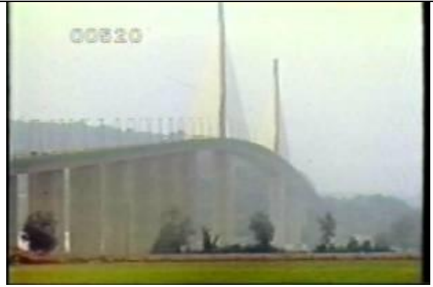
520、KRNC000916、ブロンヌ橋、斜めからほぼ全景を撮影、斜張橋、L=320m、幅員16m、高さ70m、ドイツ、ボン、
