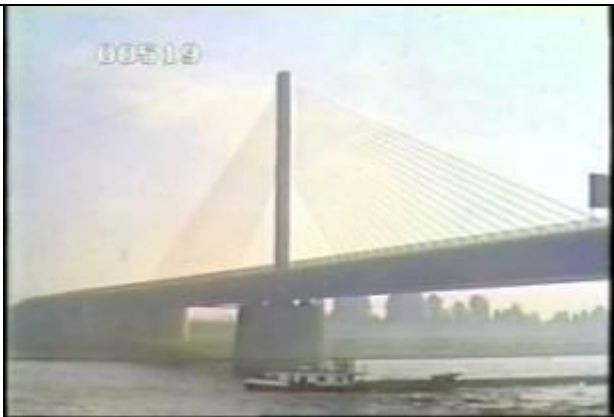
519、KRNC000509、フリードリッヒ・エーベルト橋：ボン・ノルト橋、DE、斜めからの全景、1967年建設または撮影、斜張橋
