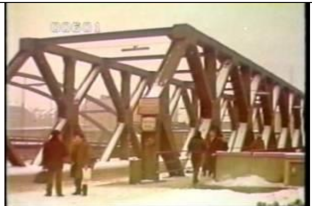
601、KRNT000201、不明橋、DE、ハンブルク、斜めから全景を撮影、トラス橋、
