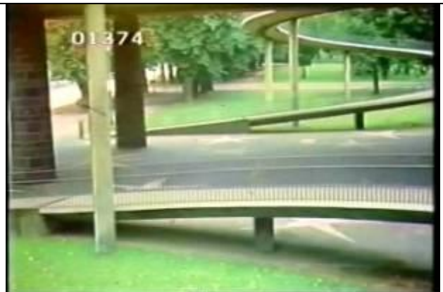
1374、MTGD000016、テオドール・ホイス橋、取り付け歩道、螺旋形歩道スロープ、1980????
