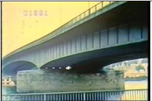
1381、SOMK000026、ドイツアー橋、DE、ケルン、ライン川、下流側(コンクリート桁)を写す、19890908
