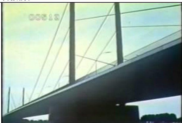
513、KRNC000105、テオドール・ホイス橋、DE、デュッ セルドルフ、ライン河、斜め下からの全景、斜張橋、 19631000
