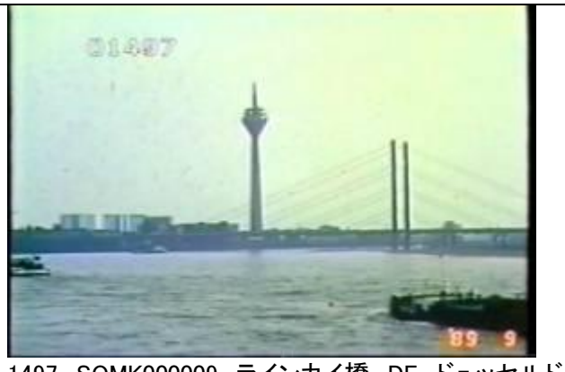
1497、SOMK000009、ラインカイ橋、DE、デュッセルドルフ、ライン川、全景、タワーとの関係、19890902
