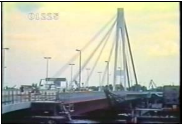
1225、KRNC000605、クルトシューマン橋、DE、マンハイム、ルードビクスハーヘン、建設中、ノルト橋、斜張橋、287.04+60.16+65.00+21.25m、197205??
