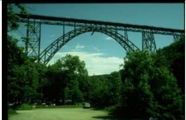
KRS049、タール橋、DE、ミュングステン、鋼アーチ、1897、160m、19 世紀の仏のガラビー橋とともに有名な鉄道橋
