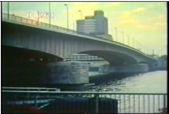
1261、MTGD000019、ケルン・ドイツ橋、DE、斜めからの撮影、PC側の側面を撮影、19800700
