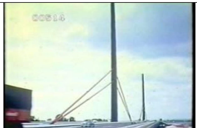
514、KRNC000114、ノルトエルベ橋、DE、ハンブルク、 斜めからの全景、斜張橋、31+64+171. 88 6+64+79. 75、19631000
