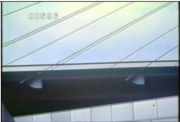
536、KRNC000507、ルードビクスハーヘン橋、DE、ルードビクスハヘン、斜め桁下から桁側のケーブル定着部を撮影、斜張橋、197205??
