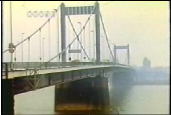
90、KRNSF10501、ローデンキルヒェン橋、DE、ケルン、ライン河、斜めから撮影した全景、吊橋、
