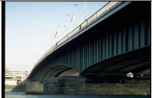
KRS097、ジョンFケネデー橋、DE、ケルン、多主桁プレートガーダー、1948、132+184+120m、典型的な多主桁変断面連続プレートガーダー
