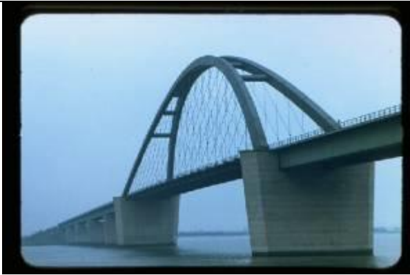
KRS064、フェーマルズンド橋、DE、プッテン島、ニールセン橋、1963、248.4、初期のニールセン形式
