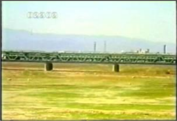
2303 2298、YMD920611、盧溝橋、CN、盧溝橋(芦溝橋) : 下流にある文化革命当時の新芦溝橋、19900400
