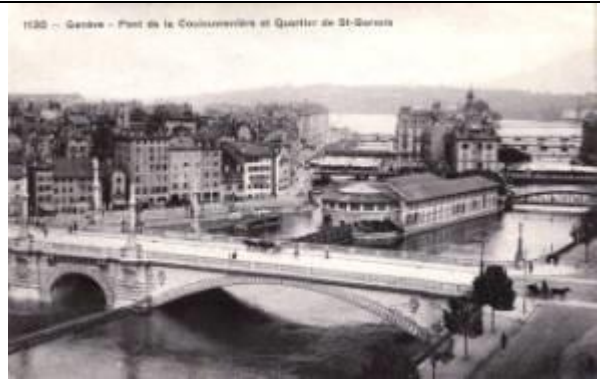
Geneve, Pont de la Coulouveniere et Quartier de St-Gervais
