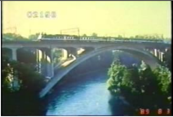
2198、SOMK000025、不明橋、CH、ベルン、アーレ川、鉄道橋、19890831
