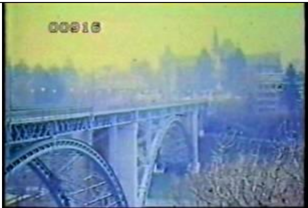
916、MTGS000001、不明橋、CH、全景、斜めからの撮影、河川橋、アーチ求Bスイスのベルンで撮影、組み合わせ部材使用、鋼橋、
