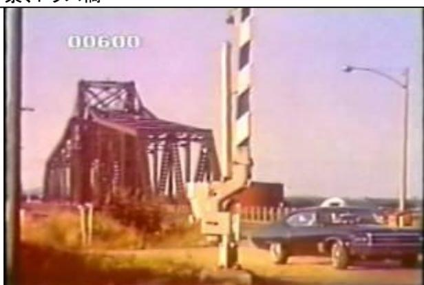
600、KRNT000516、不明橋、CA、斜めから全景を撮影、道路・鉄道併用橋、トラス橋、連絡橋？、
