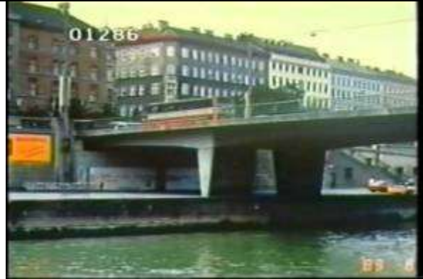
1286、SOMK000005、ザルター橋、AT、ウィーン、ドナウ運河、橋の半分と周囲の建物、19890826
