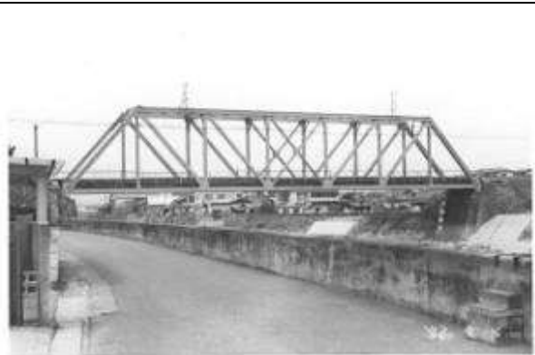
T50831、芦川橋梁、山梨県、市川大門町、三珠町、芦川、1928
