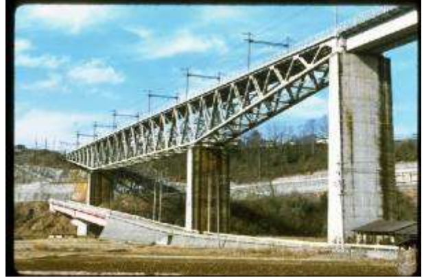
桂川橋梁, JP, 山梨県, トラス, 1968, 130m, 鉄道橋
