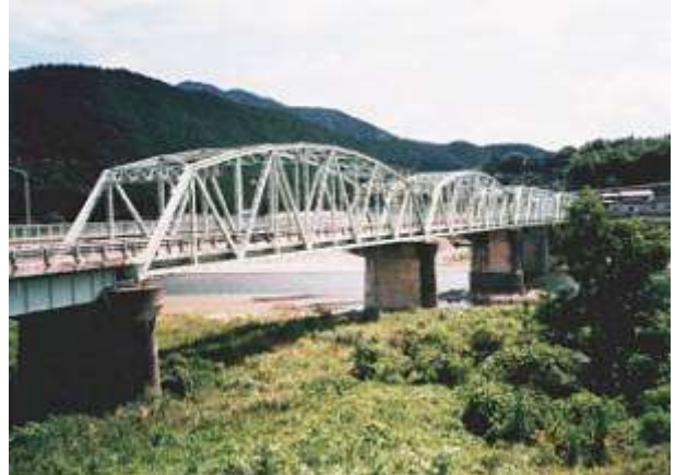
T110421、万栄橋、山梨県、南部町、富士川、県道、1960
