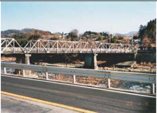
T110112、飯富橋、山梨県、中富(なかとみ)町、富士(ふじ)川、県道下部・飯富線、1953
