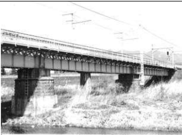
G10081、荒川橋梁(下り線)、山梨県、甲府市、荒川、中央本線、1903
