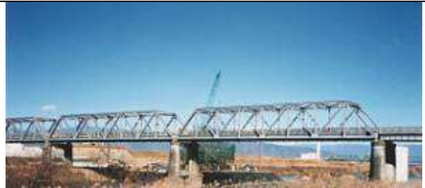
T110021、桃林橋、山梨県、田富(たのみ)町、笛吹(ふえふき)川、主要地方道甲府市川大門線、1949
