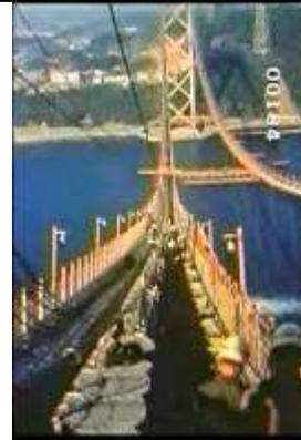
KRNSJ01018、関門橋、JP、ケーブルの架設中、塔とキャットウォーク、吊橋、19711100
