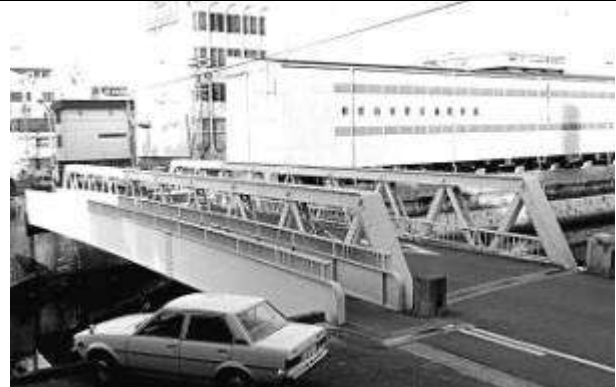
T30191、中橋、和歌山県、和歌山市、市堀川、市道、1953
