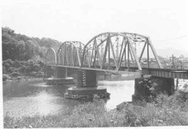
北岸(紀宝方)より見る平瀬下流曲線ワーレントラス
