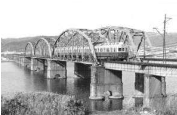
T10061、紀ノ川橋梁(上り線)、和歌山県、和歌山市、紀ノ川、南海電気鉄道、1903
