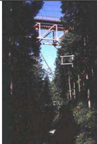
T50861、中古沢橋梁、和歌山県、九度山町、中古沢、南海電気鉄道/高野線、1928
