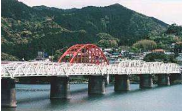
T90881、熊野大橋、和歌山県、新宮市、新宮川、国道42号、1935
