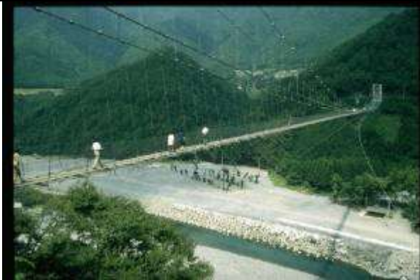
KRS081、谷瀬の吊橋、JP、和歌山、吊橋、297m、十津川峡にはこのような吊橋が数多く存在
