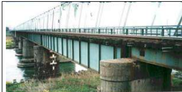
橋名: 千代川橋梁 G10091、千代川橋梁、鳥取県、鳥取市、千代川、山陰本線、1907
