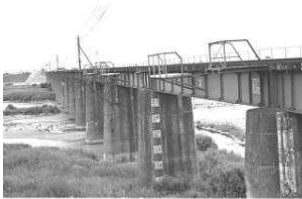
G10211、鮎喰川橋梁、徳島県、徳島市、鮎喰川、徳島線、1899
