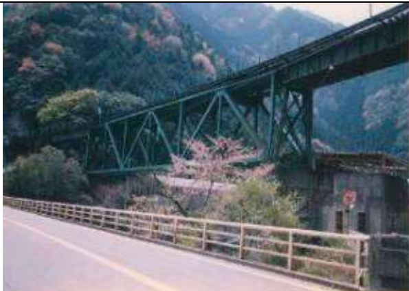
T51471、白川橋梁、徳島県、山城町、白川、土讃線、1935
