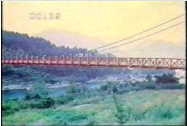
129、KRNSJ00703、不明橋、JP、吉野川、ほぼ全景を撮影、トラス補剛桁吊橋、19670600
