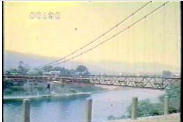
130、KRNSJ00701、不明橋、JP、吉野川、ほぼ全景を撮影、トラス補剛桁吊橋、19670600
