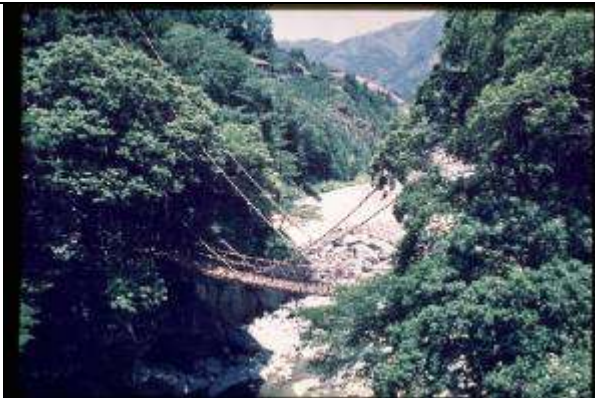
KRS074、かずら橋、JP、祖谷、吊橋、1928、古来の様式を踏襲したかずら橋、実は針金を用いた吊橋
