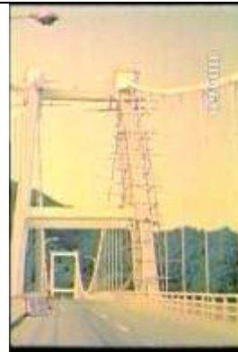
460、KRNSJ00711、小鳴門橋、JP、入口の路面上で撮影、吊橋、19670600
