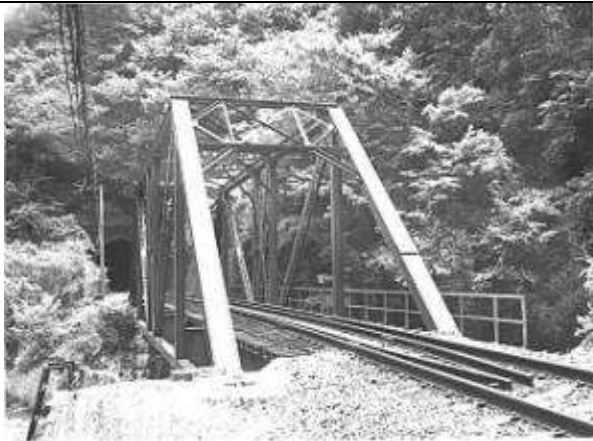
T20101、洲津川橋梁、徳島県、池田町、洲津川、土讃線、1954
