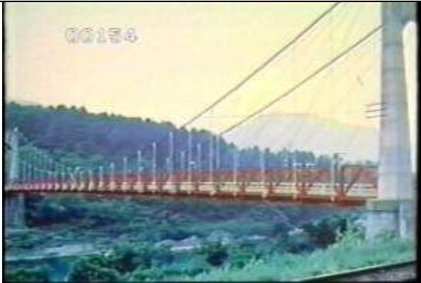
154、KRNSJ00704、不明橋、JP、吉野川、全景を撮影、トラス補剛桁吊橋、19670600
