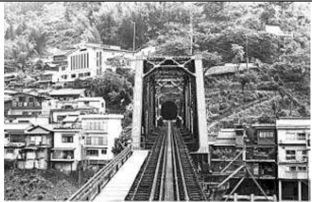
T20291、伊予川橋梁、徳島県、山城町、伊予川、土讃線、1950
