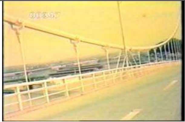
347、KRNSJ00710、小鳴門橋、JP、路面上でケーブル面を撮影、吊橋、19670600
