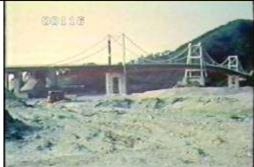
116、KRNSJ00707、小鳴門橋、JP、全景、吊橋、19670600
