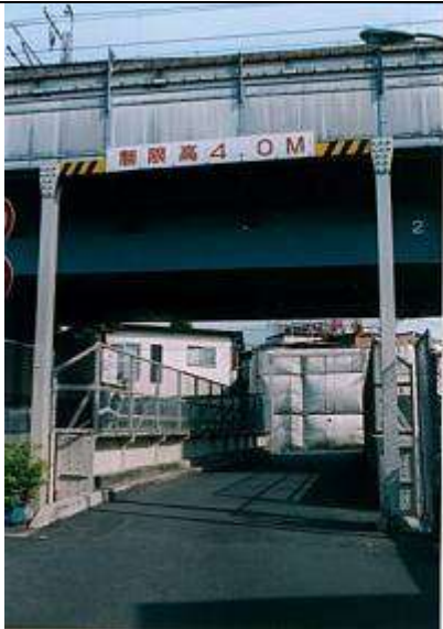
G10501、霜田跨線橋、東京都、(東海道貨物線)、下路板桁、
