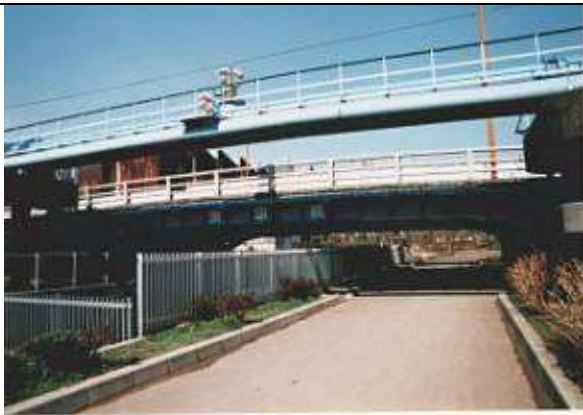
G70361、小石川橋、東京都、千代田区、神田川、中路ダブルウェブ板桁、
