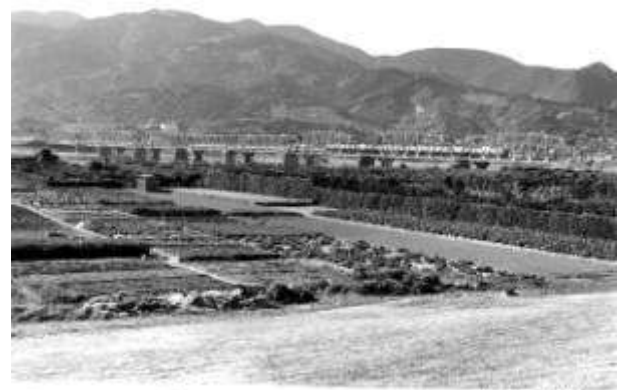
T10251、富士川橋梁(下り線)、静岡県、富士市、富士川町、富士川、1915
