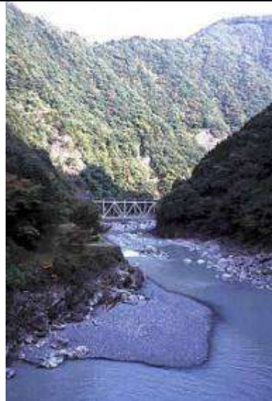
T51511、第一大井川橋梁、静岡県、本川根町、大井川、大井川鉄道/井川線、1953
