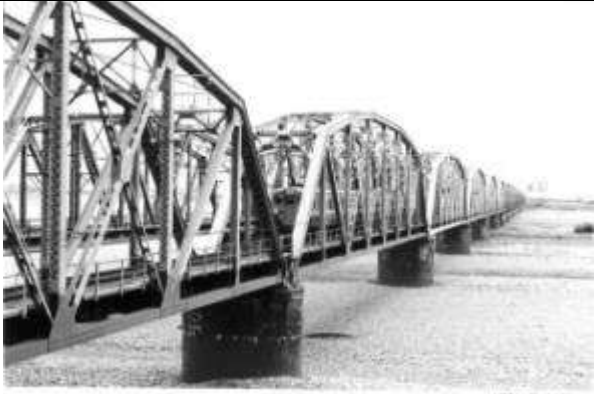
T10261、大井川橋梁(下り線)、静岡県、島田市、金谷町、大井川、1915
