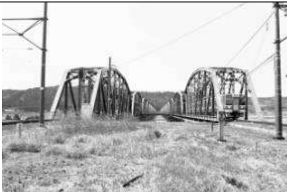
T100271、大井川橋梁上り線、静岡県、島田市、金谷町、大井川、1959
