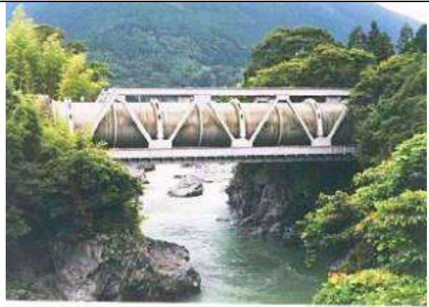
撮影: 藤井郁夫, 1995-9-15 写真: 藤井郁夫 T91061、釜口サイホン橋、静岡県、芝川町、富士川、日本軽金属(株)富士川第二発電所(蒲原)用送水管、1942
