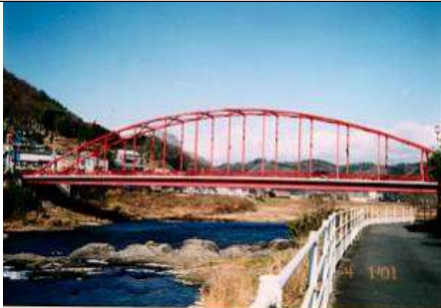
A70041.、釜口橋、静岡県、芝川町、富士川、①下路ランガートラス、1951
