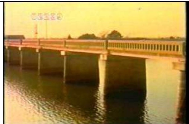
2239、BBS9208113、豊浜橋、JP、静岡県、福田町、昭和8年建設、コンクリート桁14、19??????
