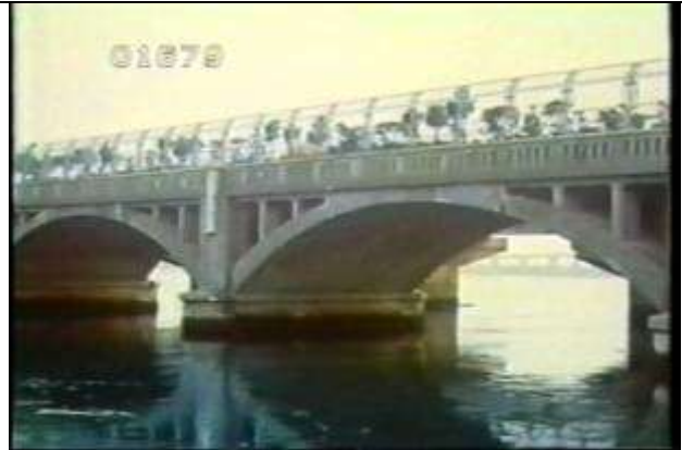
1679、BBS9208310、旧中浜名橋、JP、静岡県、舞阪町、全景、昭和4年建設、コンクリートアーチ橋12、19??????
