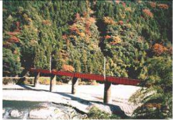
G20271、大井川第三橋梁、静岡県、本川根町、大井川、大井川鉄道、1931
