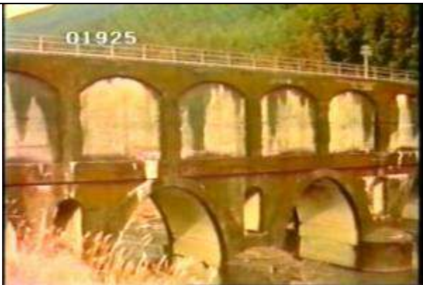
1925、BBS9208419、長尾川水路橋、JP、静岡県、中川根町、昭和19年建設、コンクリートアーチ橋23、19??????
