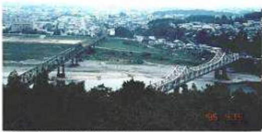
右が鹿島橋 左は天竜浜名湖鉄道天竜川橋梁 (撮影: 藤井郁夫, 1995-9-15) T90301、鹿島橋、静岡県、天竜市、天竜川、国道 152 号、1937
