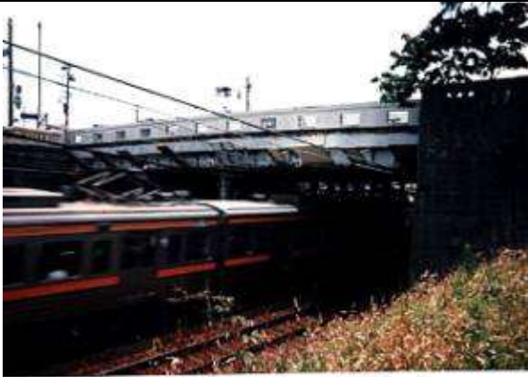
G70141、桜橋(工事名 入江跨線橋)、静岡県、清水市、跨東海道本線、静岡鉄道、1931
