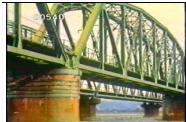
540、BBS9208305、JR大井川橋梁下り線、JP、静岡県、金屋町、大正4年建設、トラス橋15、19??????
