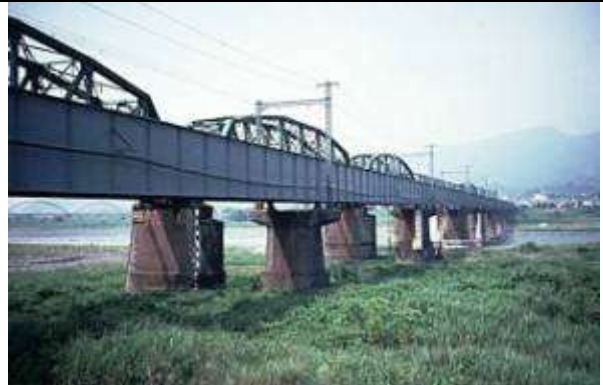
G80017、富士川橋梁、静岡県、富士市、富士川、東海道本線(上り線)、1955
