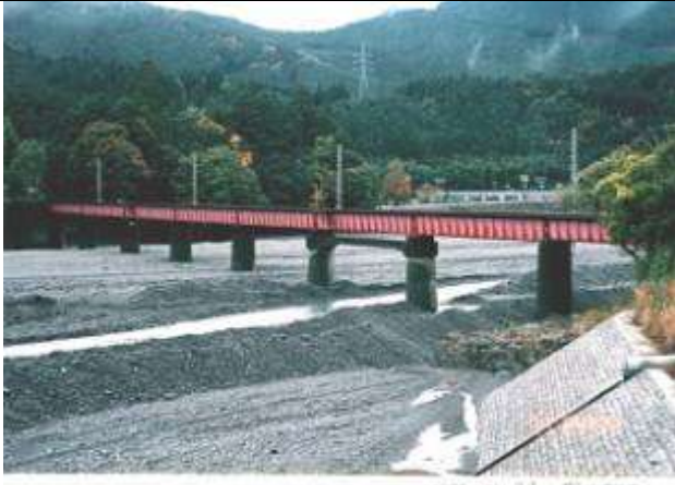
G20261、大井川第四橋梁、静岡県、本川根町、大井川、大井川鉄道、1931
