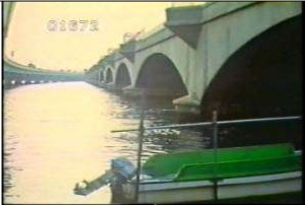
1672、BBS9208311、旧西浜名橋、JP、静岡県、舞阪町、昭和7年建設、コンクリートアーチ橋30、19??????
