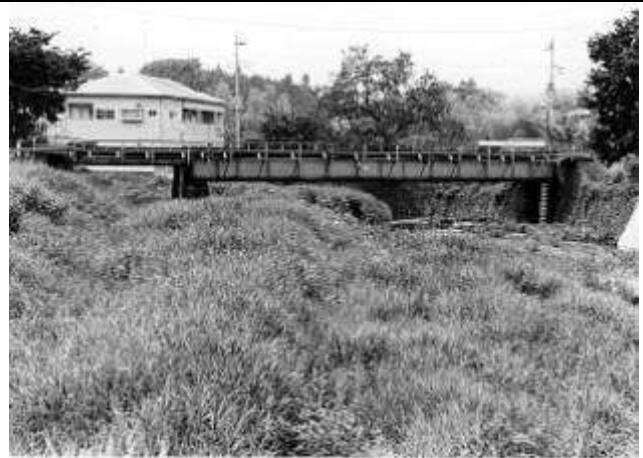
G10411、毛呂川橋梁、埼玉県、毛呂山町、越生町、毛呂(もろ)川、1934
