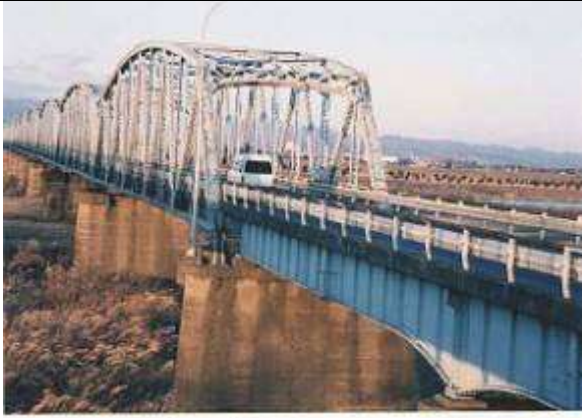
T90841、上武大橋、埼玉県、深谷市、利根川、県道、1934
