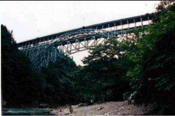
A50141、荒川橋、埼玉県、秩父郡荒川村、荒(あら)川、国道 140 号、1929
