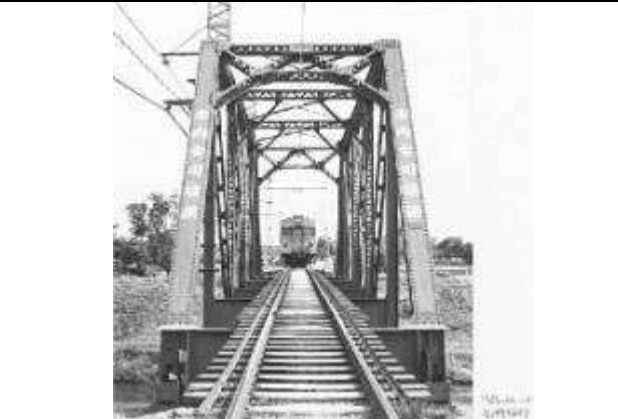
T51171、庄内古川橋梁、埼玉県、庄和町、春日部市、庄内古川、1930
