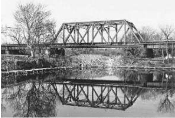
1984-11-30 高野清行 T51052、矢田川橋梁、埼玉県、北川辺町、板倉町、矢田川、1929
