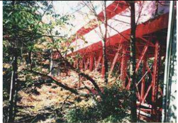
T80191、常盤橋、埼玉県、荒川村、浦山川、府県道(建設時) 国道 140号(現在)、1925
