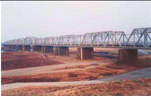
T51033、利根川橋梁、埼玉県、大利根町、北川辺町、利根川、1929
