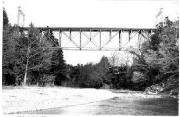
T20251、浦山川橋梁、埼玉県、荒川村、浦山川、秩父鉄道、1930
