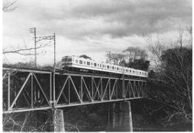
T50632、荒川橋梁、埼玉県、寄居町、荒川、東武鉄道 / 東上線、1925
