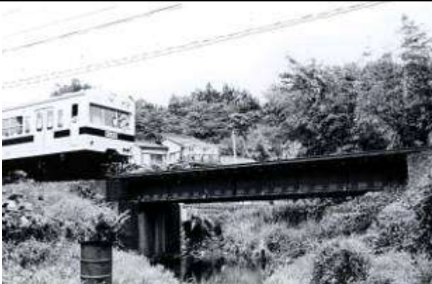
G10301、逆川橋梁、埼玉県、寄居町、逆川、秩父鉄道、1903
