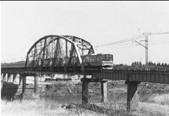
川越市荒川橋梁トラス部 撮影：菅田秀吉 T51581、荒川橋梁、埼玉県、大宮市、川越市、荒川、1940
