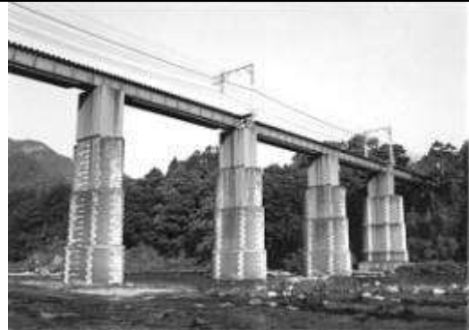
G10052、荒川橋梁、埼玉県、長瀬町、皆野町、荒川、1914
