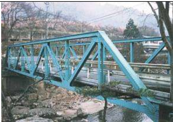
T91031、栄橋、岡山県、小田郡矢掛町、星田川、町 道、1939
