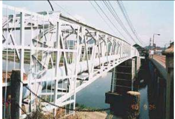
T70081、京橋水管橋(旭川水管橋)、岡山県、岡山市、旭川、岡山市水道、1905
