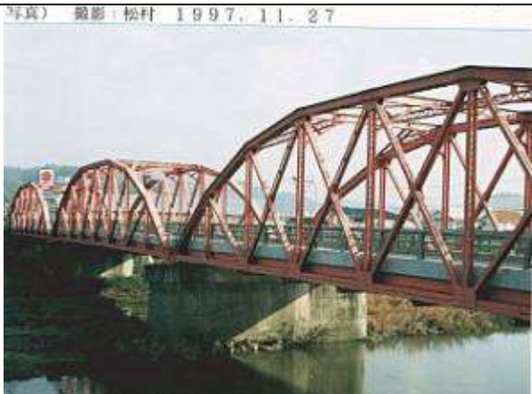
写真) 撮影：松村 1997. 11. 27 T80211、日芳橋、岡山県、井原市～七日市町、小田川、井原市道、1926
