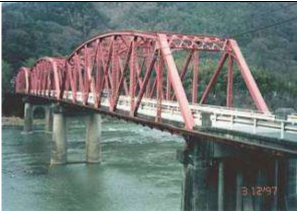
T90931、玉川橋、岡山県、高梁市、高梁川、県道宇 戸谷高梁線、1936
