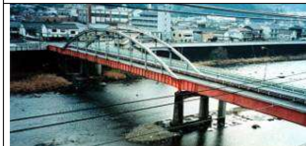
A50741、方谷橋、岡山県、高梁(たかはし)市、高梁(たかはし)川、市道、1937
