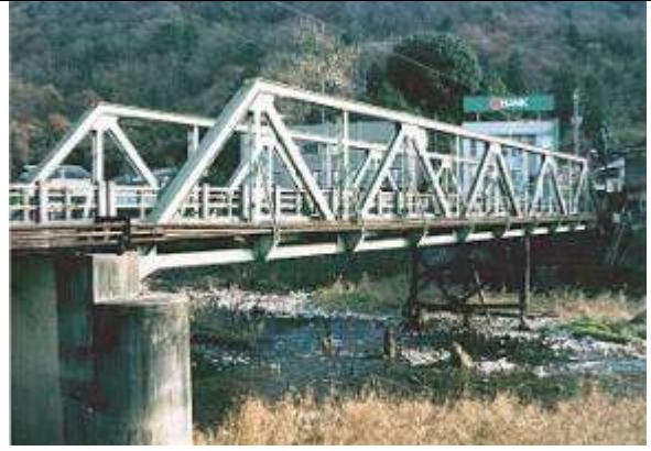
T90811、(旧)川辺橋、岡山県、吉備郡真備町～都窪 郡清音村、高梁川、県道、1933
