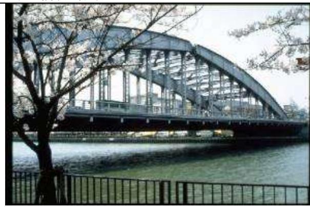
KRS070、桜宮橋、JP、大阪、3ヒンジアーチ、1930、188m、地盤沈下に対応
