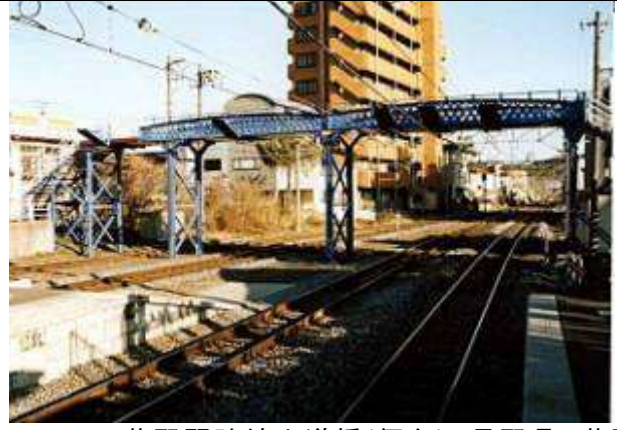
G70823、茅野駅跨線人道橋(仮名)、長野県、茅野 市、跨線橋(中央本線茅野駅)、市道、1930
