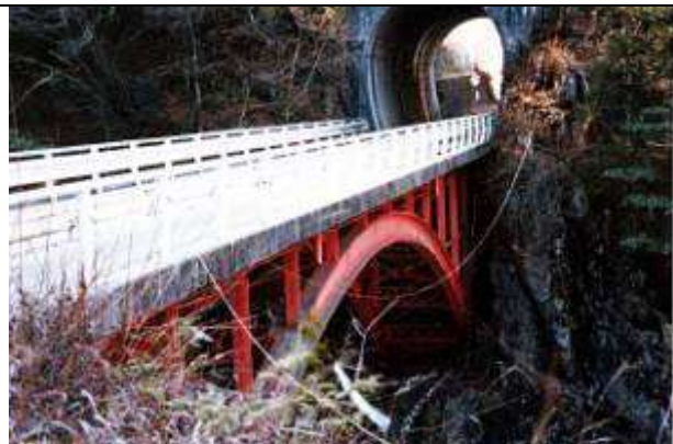
A20101、大鹿淵橋梁(大鹿淵橋)、長野県、王滝村、王滝川、(旧)王滝森林鉄道、1923
