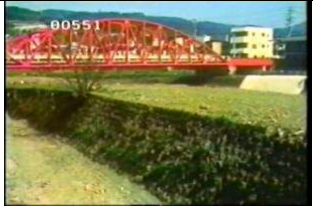
551、BBS9208206、釜口橋、JP、長野県、岡谷市、昭和6年建設、トラス道路橋28、19??????
