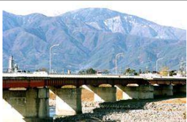
G70121、梓橋、長野県、松本市、梓川、国道 147 号(建設時県道)、1931
