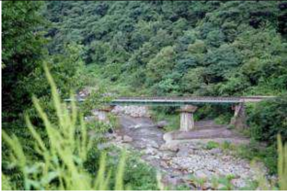
G30062、第六千曲川橋梁、長野県、小海町、千曲川、小海線、1932
