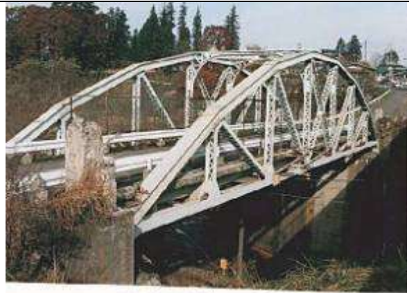
撮影 水口 洋敏 1968年11月13日 改定2000年11月5日 改定 藤井 悠夫 T90751、北国街道跨線橋、長野県、信濃町、跨線橋(信越本線)、町道 旧国道18号、1933
