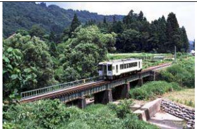
G20221、野々海川橋梁、長野県、飯山市、野々海川、飯山線、1923
