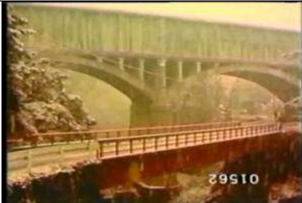
1562、BBS9208417、柿其水路橋、JP、長野県、南木曾町、大正12年建設、コンクリートアーチ橋20、19??????
