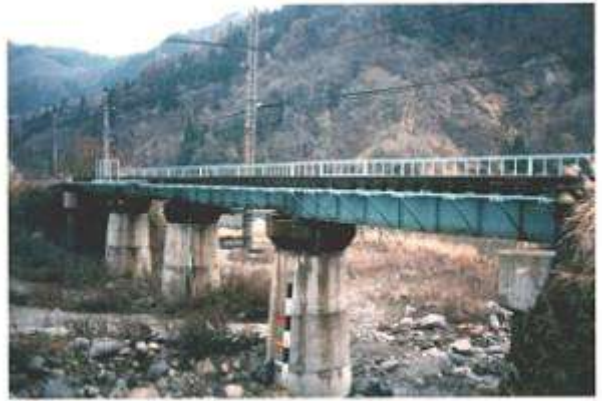
G10451、親ノ沢橋梁、長野県、小谷村、親ノ沢、大糸線、1935
