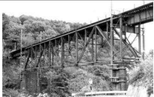
T60051、立場川橋梁、長野県、富士見町、立場川、国鉄中央本線、1904
