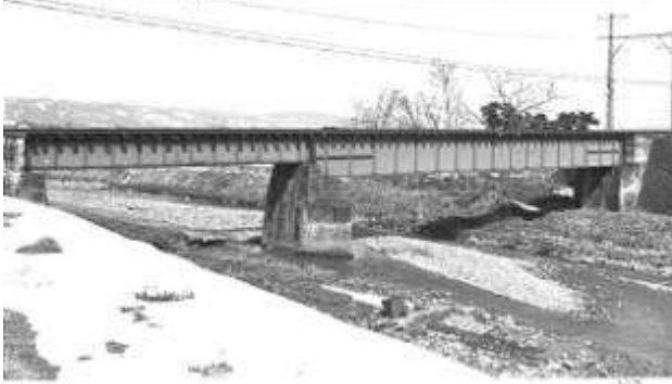
G10061、鮎川橋梁、長野県、須坂市、鮎(あゆ)川、長野電鉄/河東線、1922
