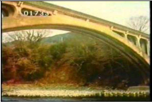
1733、BBS9208312、坂戸橋、JP、長野県、中川村、昭和8年建設、コンクリートアーチ橋17、19??????
