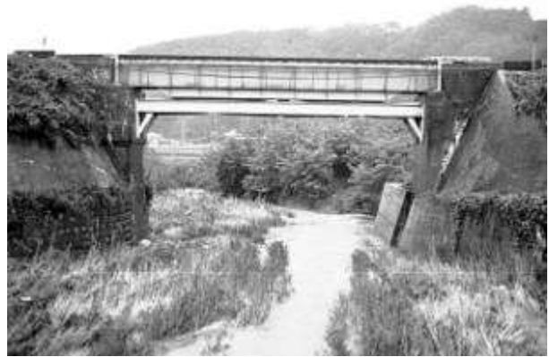
G10291、麻績川橋梁、長野県、麻績村、麻績川、篠ノ井線、1900
