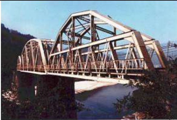
T10022、犀川橋梁上り線、長野県、長野市、犀川、 信越本線、1957
