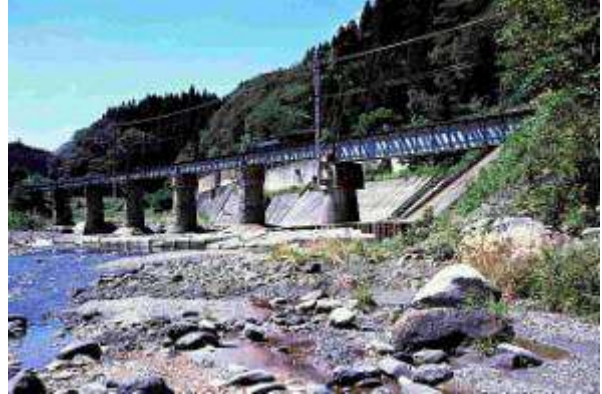
G30101、第二姫川橋梁、長野県、小谷村、姫川、大糸線、1935
