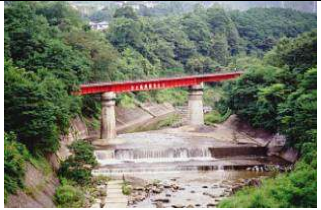
G30071、第七千曲川橋梁、長野県、小海町、千曲川、小海線、1932
