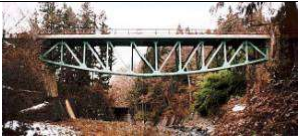
T90251、子安橋、長野県、上高井郡高山村、杵沢川、県道、1933
