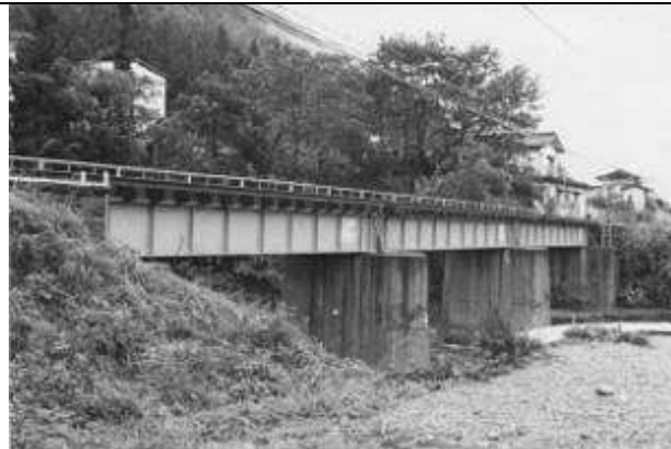
G10341、第一横川川橋梁、長野県、辰野町、横川川、中央本線、1906
