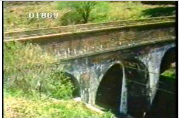
1869、BBS9208414、蔵造川水路橋、JP、長野県、塩尻市、明治39年建設、煉瓦マーチ橋6、19??????
