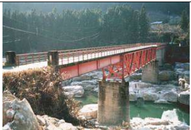
T110301、柿其橋、長野県、南木曾(なぎそ)町、柿其(かきぞれ)川、林道、1957
