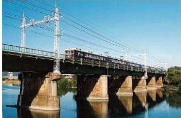
G20243、桂川橋梁、京都府、京都市、桂川、阪急電鉄京都線、1928
