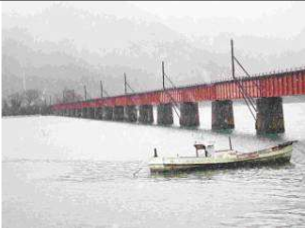
G20033、由良川橋梁、京都府、舞鶴市、宮津市、由良川、1924
