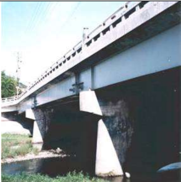
G70711、御蔭橋、京都府、京都市北区、鴨川、府道、1937
