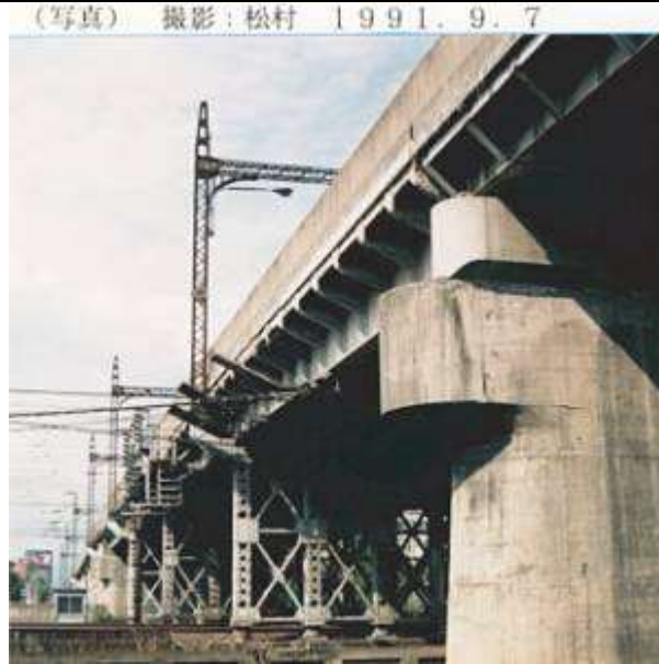
G70641、大宮跨線橋、京都府、京都市下京区～南区、跨・JR 東海道本線、府道、1935
