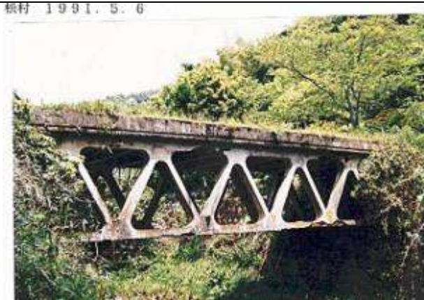
T80021、二ノ瀬橋、京都府、京都市左京区、鞍馬川、府道(旧道)、1914
