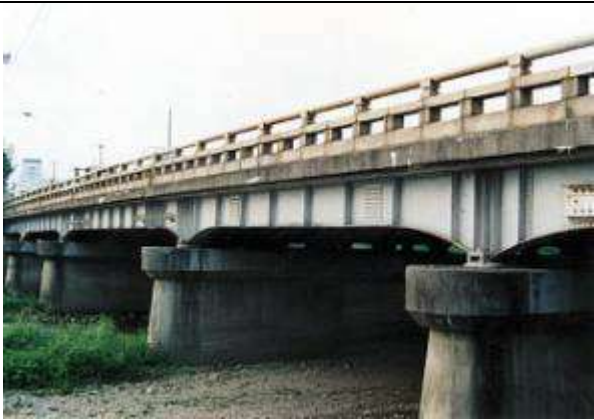
G70211、高野橋、京都府、京都市左京区、高野川、国道 367 号、1932
