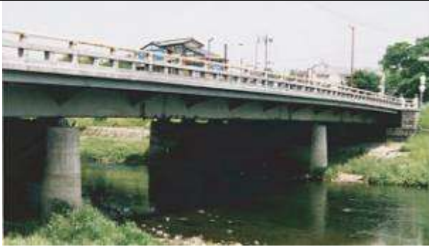
G90221、葵橋、京都府、京都市左京区～上京区、賀茂川、府道、1956
