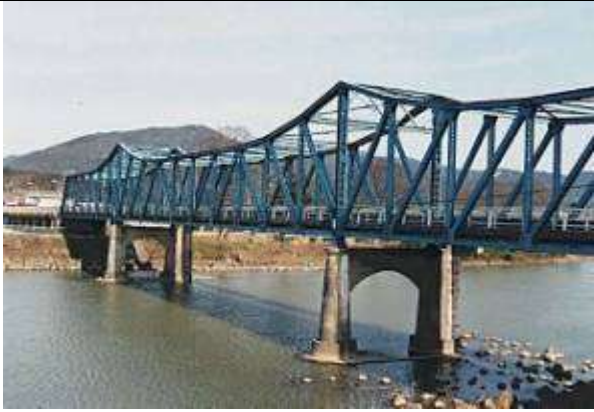
T90281、大堰橋、京都府、船井郡八木町、大堰川、府道、1935
