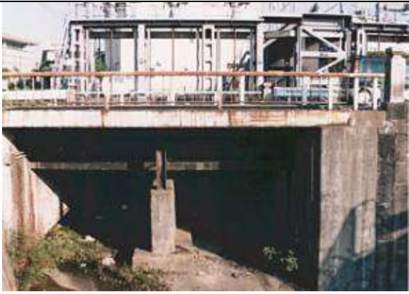
G50031、福稲橋、京都府、京都市東山区福稲上高松町、疏水派川、市道墨染通線、1912
