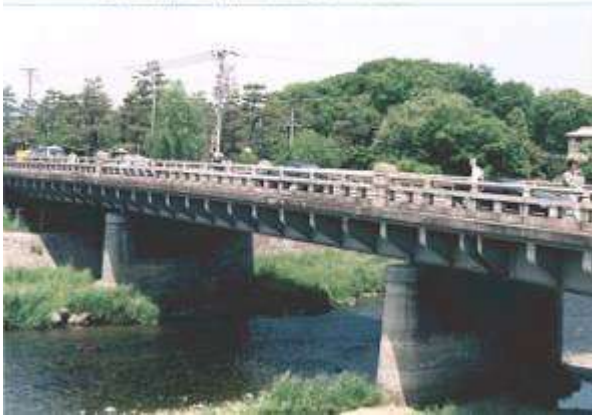
G70771、河合橋、京都府、京都市左京区、高野川、市道、1938
