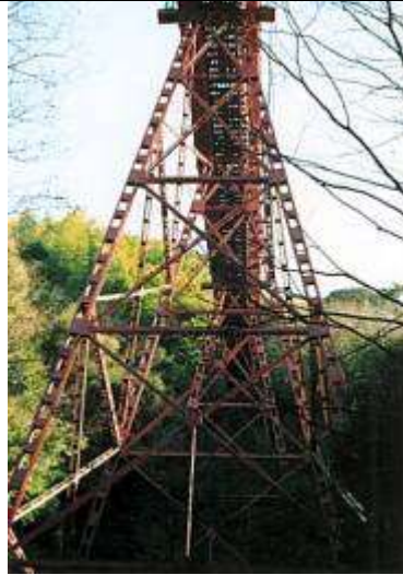
T100141、男山索道橋、京都府、八幡市、京阪電気鉄道/鋼索線、1955
