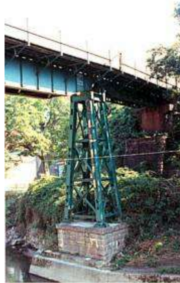
G40022、下の川橋梁、京都府、笠置町、下の川、関西本線、1897
