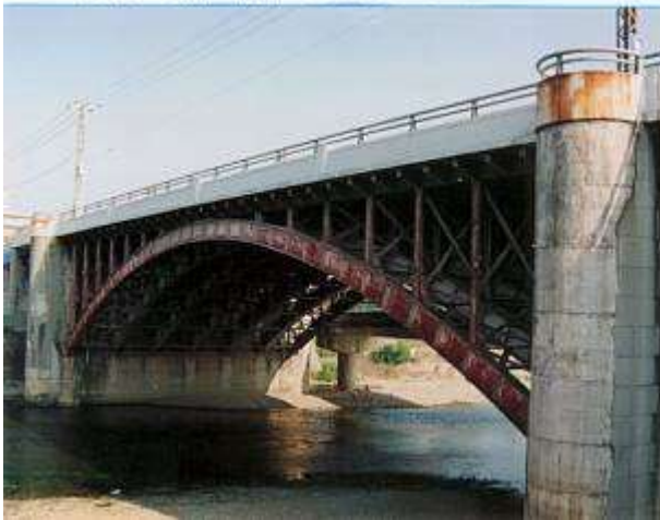
A50671、九条跨線橋、京都府、京都市南区東九条南河原町～東山区本町一四丁目、鴨川及び疏水及び京阪本線、府道四ノ宮四ツ塚線、1933???????????
