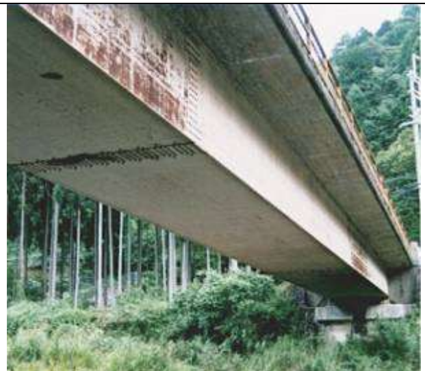
G90182、八桷橋、京都府、京都市左京区、桂川、府道、1955
