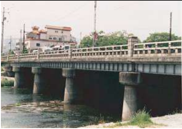
G70591、北大路橋、京都府、京都市左京区～北区、鴨川、国道 367 号、1933
