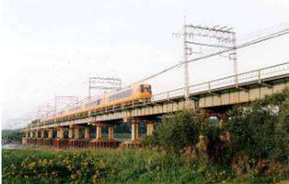
G20251、木津川橋梁、京都府、木津川、近鉄京都線、1928
