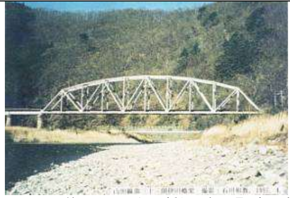
T100041、第三十三閉伊川橋梁、岩手県、新里村、閉伊川、山田線、1950
