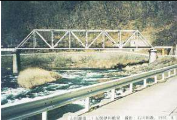
T100111 第二十五閉伊川橋梁、岩手県、川井村、閉伊川、山田線、1930、
