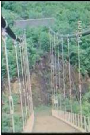
354、KRNSJ00405、白金橋、JP、路面上でケーブル、ハンガーと床版を撮影、吊橋、
