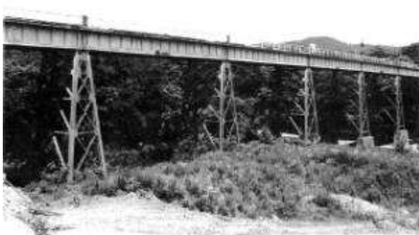
G70271、青岩橋、岩手県、二戸市～青森県三戸町、馬淵川、国道4号、1935
