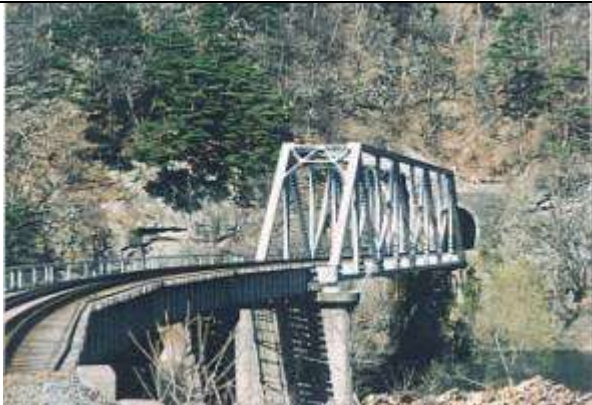
T100031、第三十二閉伊川橋梁、岩手県、新里村、閉伊川、山田線、1950
