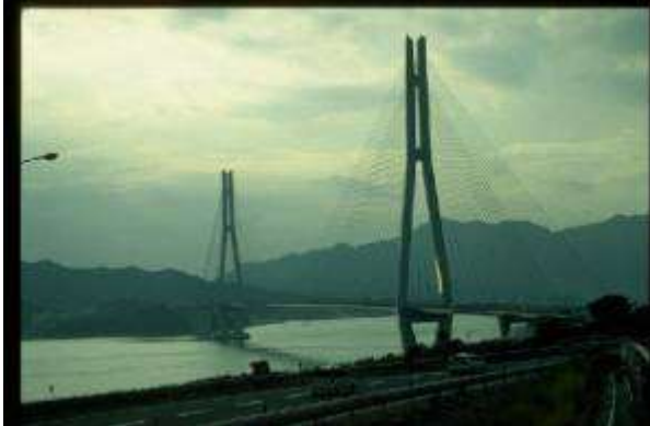
KRS091、多田羅大橋、JP、海なみハイウェイ、複合斜張橋、1998、890m、世界最長の斜張橋
